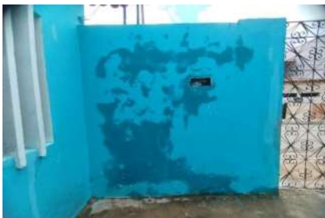
Figura 7 – Infiltração na alvenaria da área livre. Fonte: Autor (2023).
