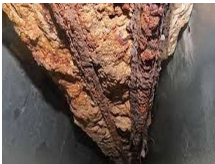
Figura 4 - Corrosão da estrutura de aço.
