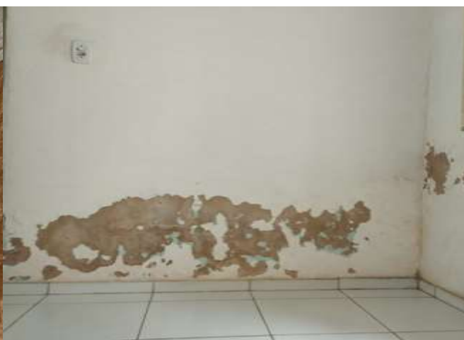
Figura 11 – Calcinação presente na alvenaria da cozinha 1.
