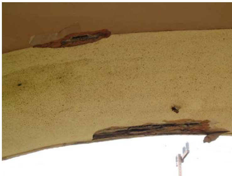
Figura 5 – Viga do Pavimento Térreo apresentando concreto desagregado
