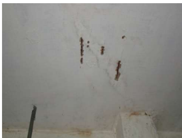
Figura 7 – Laje da garagem em estado inicial de corrosão
