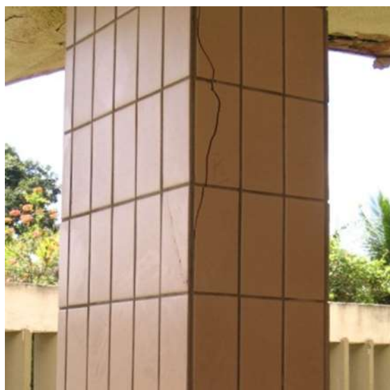
Figura 4 – Outro pilar apresentando início evidente de oxidação da armadura
