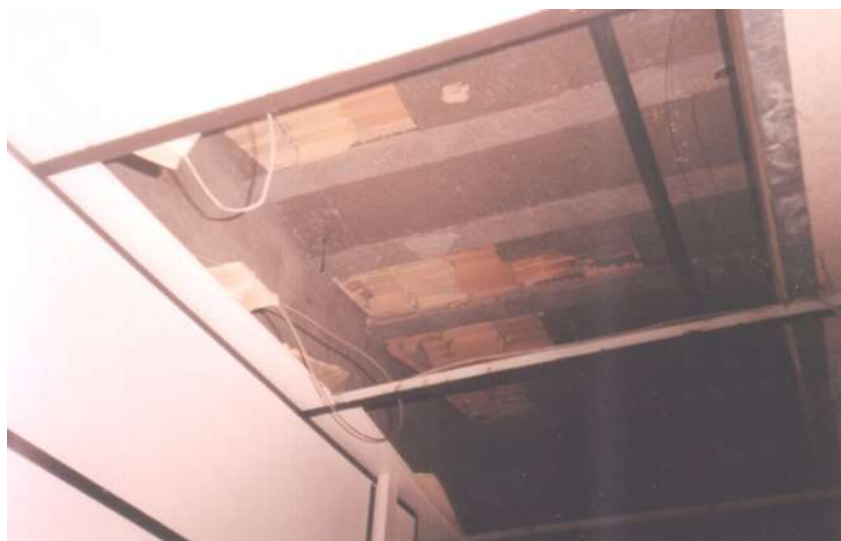
Figura 17 – Visão dos blocos cerâmicos, face inferior da laje junto ao apoio
