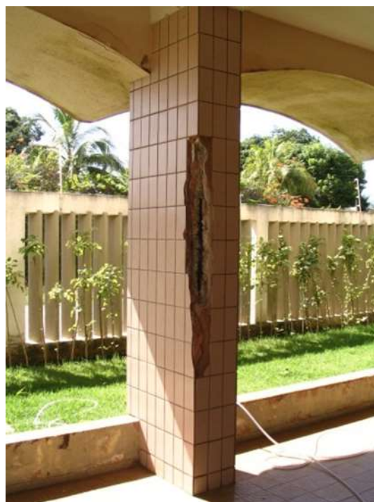
Figura 3 – Pilar apresentando forte oxidação das armaduras
