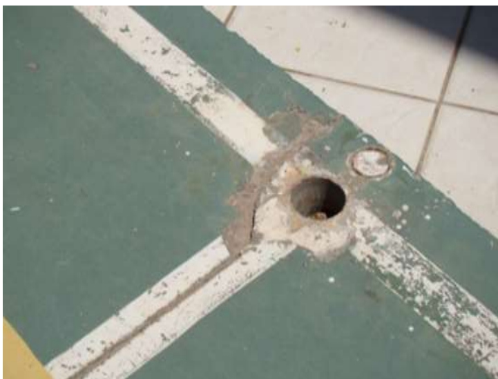
Figura 9 – Trinca de movimentações térmicas devido à execução indevida da junta de dilatação
