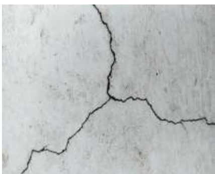
Figura 1 – Fissuras. Fonte: Ferreira (2016).
