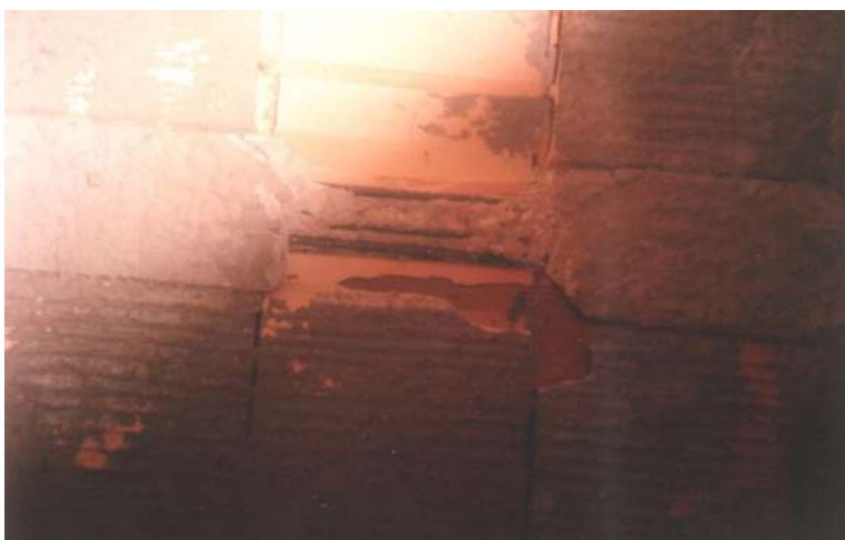
Figura 12 – Abertura efetuada em uma vigota da laje a fim de determinar a armação existente
