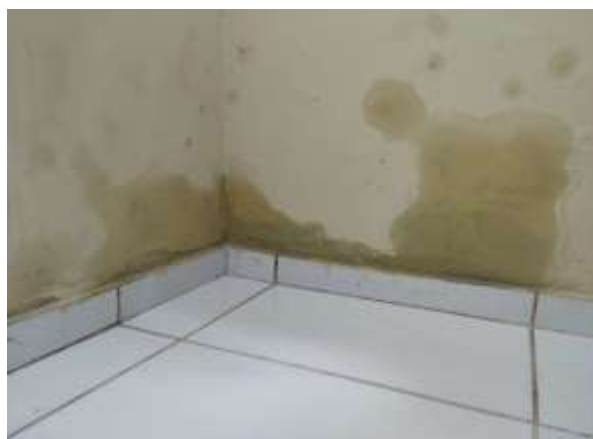
Figura 8 – Infiltração na alvenaria da sala. Fonte: autor (2023).
