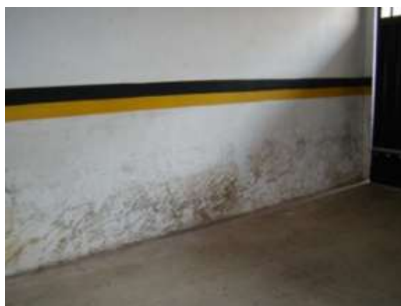
Figura 8 - Paredes da garagem apresentando infiltração
