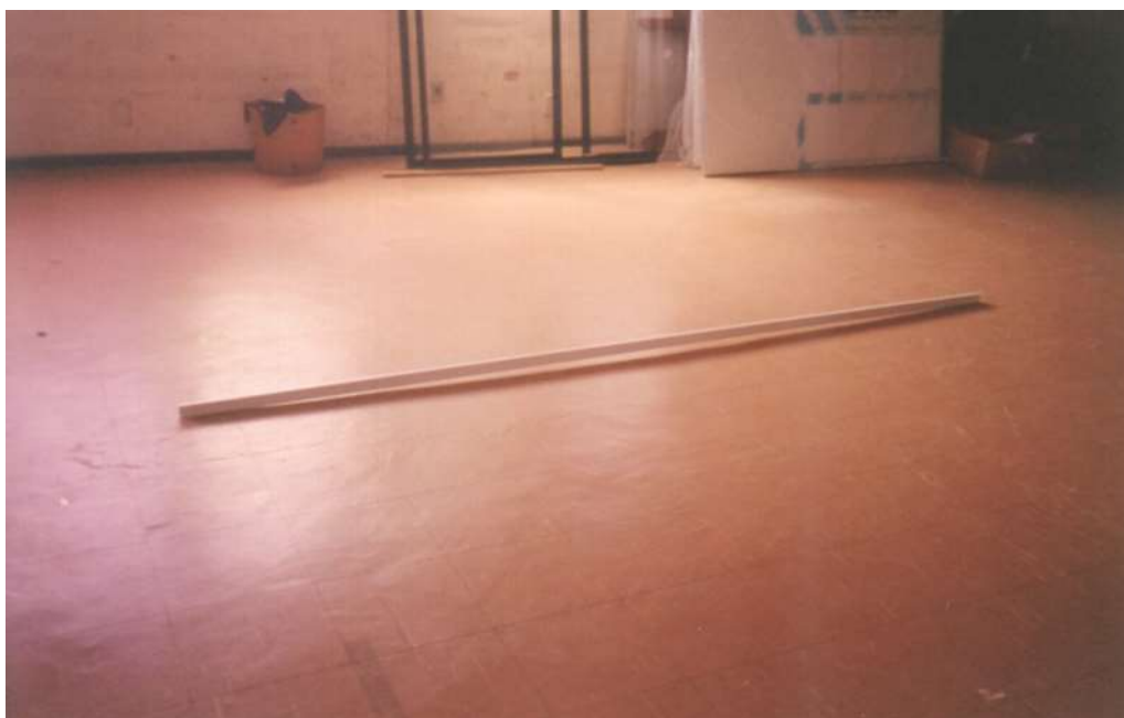
Figura 11 – Laje apresentando flecha exagerada
