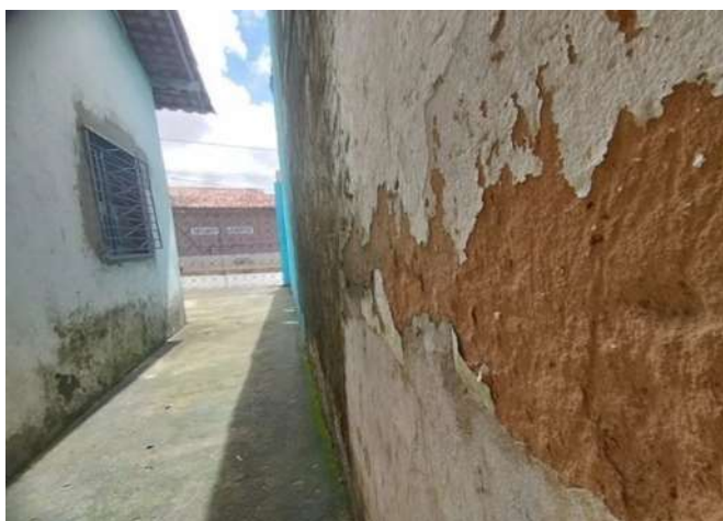
Figura 10 – Calcinação presente na alvenaria da área livre.
