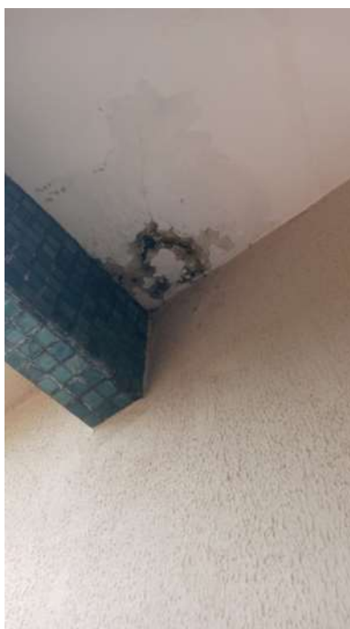
Figura 3. Bolor no teto do Fórum da Comarca de Edéia
