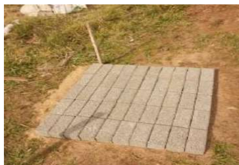
Figura 6- Blocos Inter travados.
