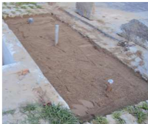
Figura 3-Camada de areia sobreposta a camada de bidim
