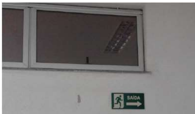
Figura 8 – Sinalização de emergência.
