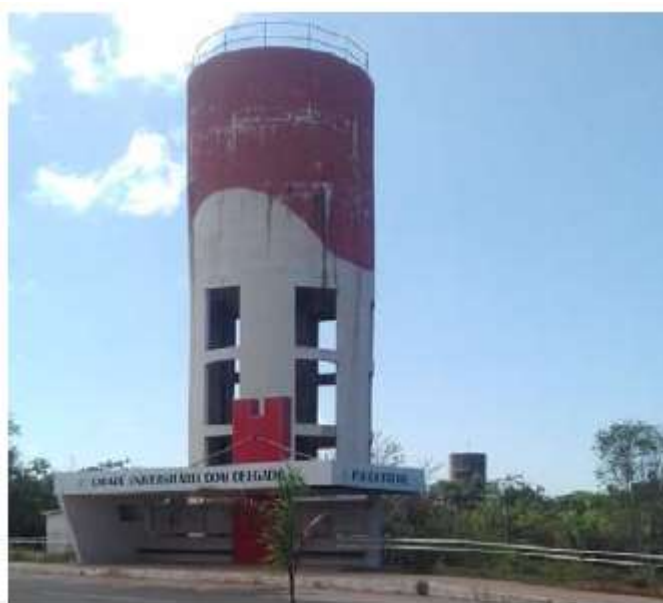
Figura 6 – Reservatório de água
