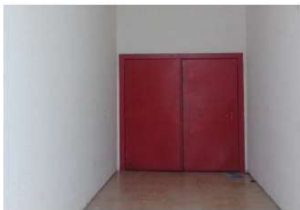
Figura 9 – Saída de emergência.
