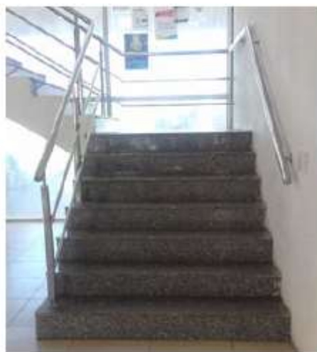
Figura 10 – Saída de emergência, escadas.
