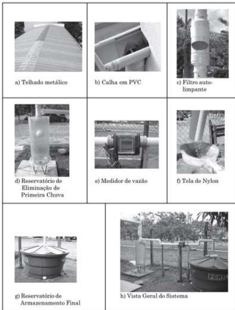
**Figura 3** – Sistema de coleta, tratamento simplificado e armazenamento da água de chuva da UFES [6].
