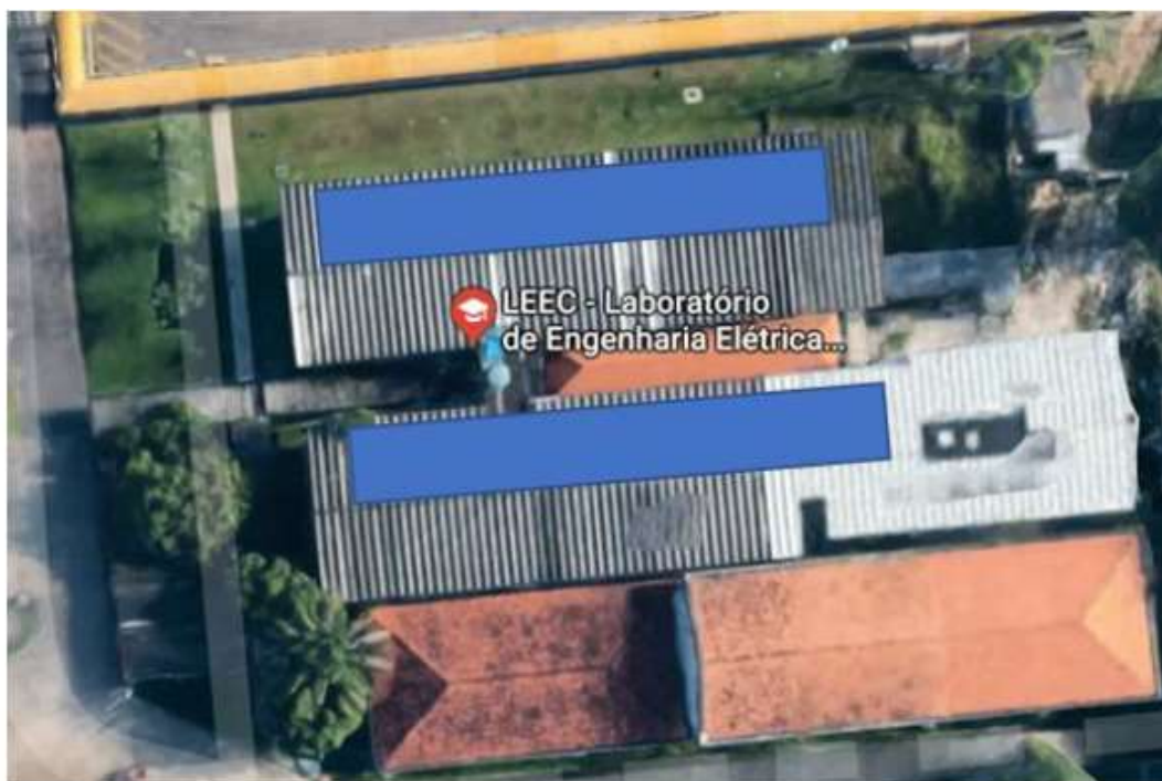
Figura 3: Disposição dos arranjos nas coberturas voltadas para o Norte
