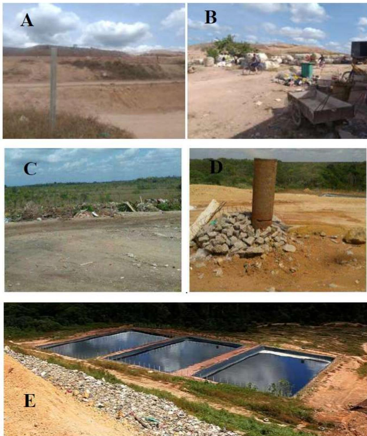
**Figura 3:** A- Célula de resíduos domésticos, B-célula de armazenamento de resíduos recicláveis; C- célula entulho, célula de resíduos domésticos, D- dreno de gás metano e E- lagoas de estabilização.
