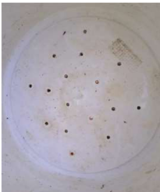
Figura 03 – Furos de drenagem
