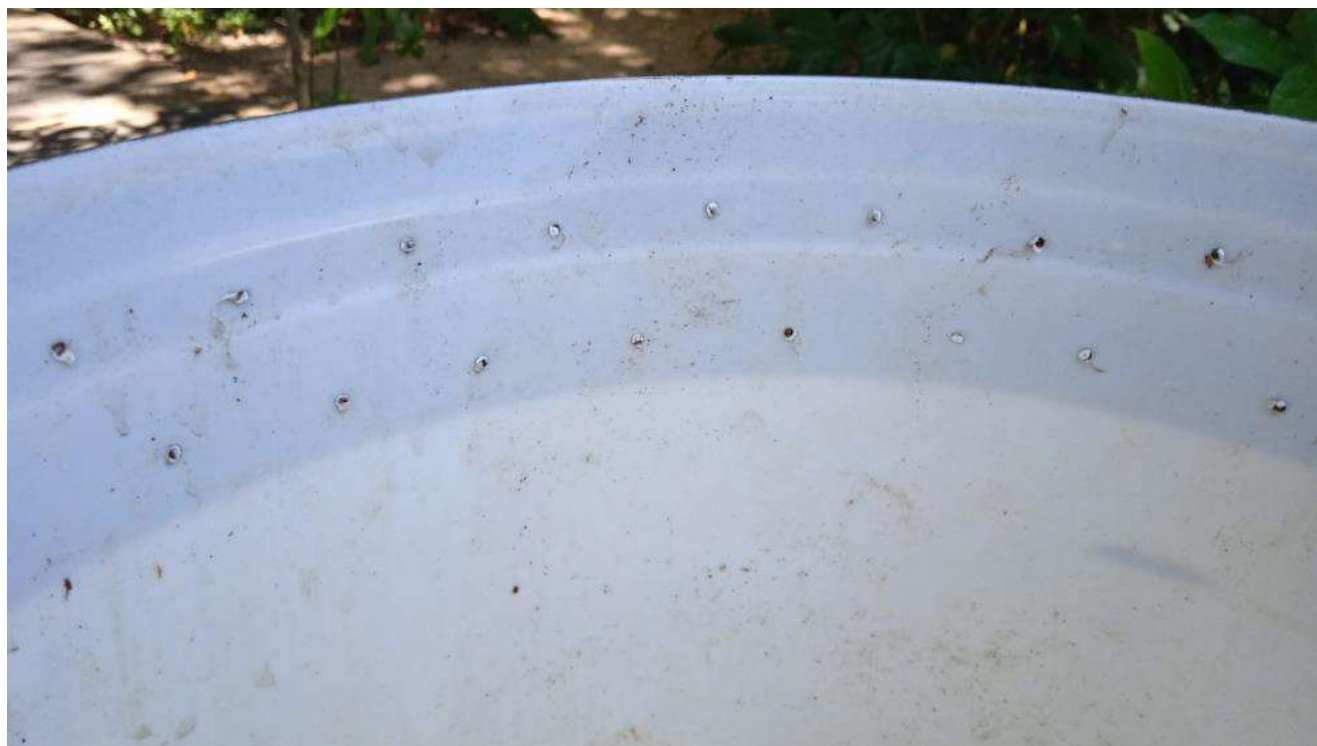
Figura 04 – Janelas de ventilação
