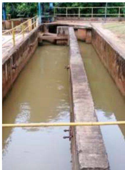
Figura 14. Caixas de retenção de areia.
