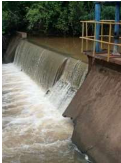
Figura 13. Barragem de nível no Ribeirão São Lourenço.
