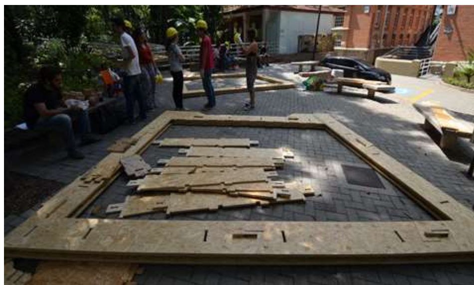
Figura 12 – Os dois pórticos montados no chão.
