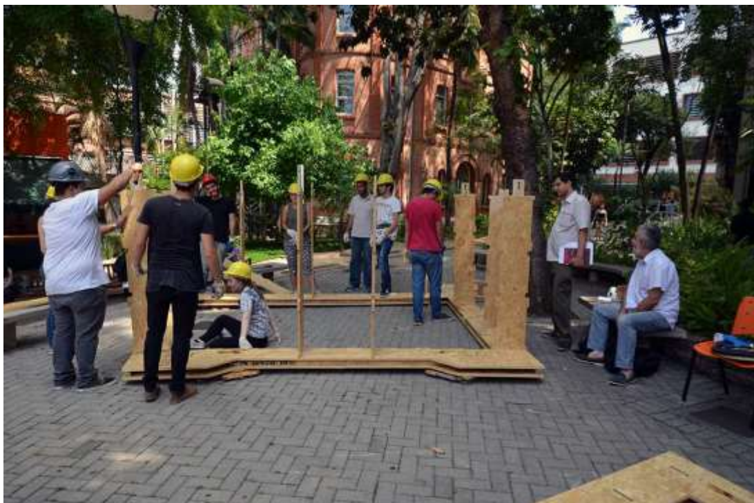
Figura 13 – Fixação dos travamentos perpendiculares.
