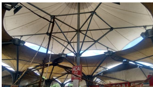
Figura 10: Estrutura Feira Coberta Cidade Nova 4
