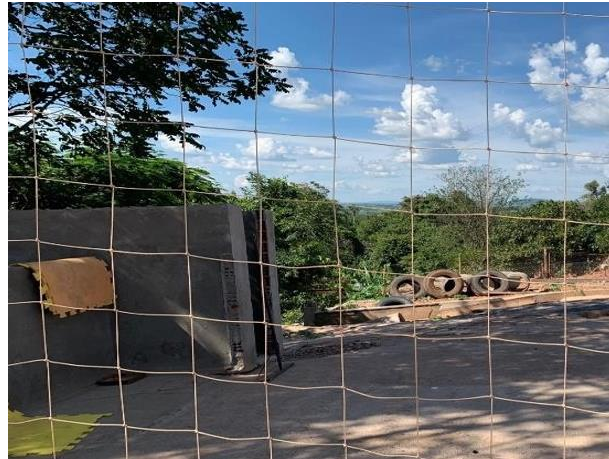
Figura 3-Visão geral do local de dentro da quadra de esporte
