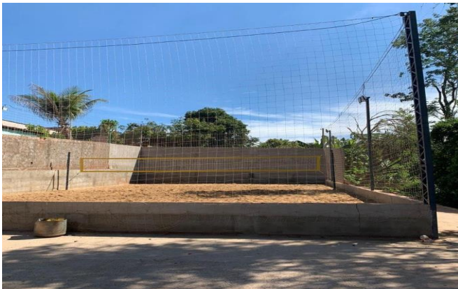
Figura 4-Visão geral do local
