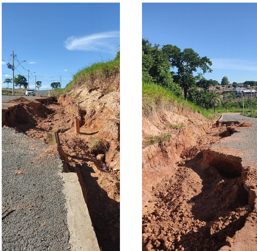
Figura 4- Início da reconstrução da via
