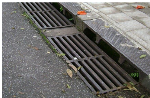
Figura 11 -Exemplo de boca de lobo combinada
