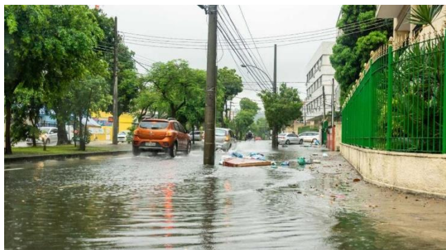
Figura 8- Exemplo de situação da falta de drenagem
