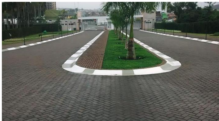
Figura 10 -Via de condomínio em piso drenante.
