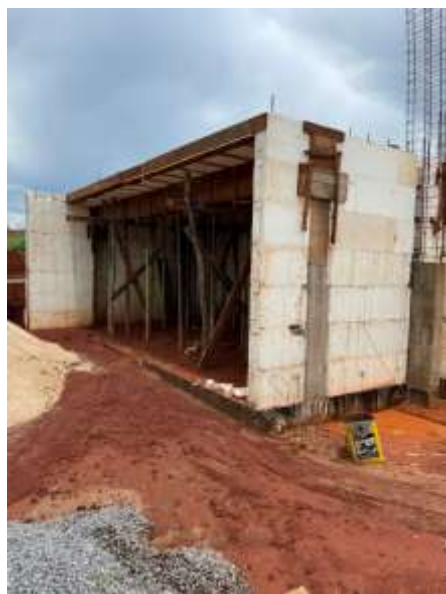
Figura 10-Escoramento e concretagem da laje da sala comercial
