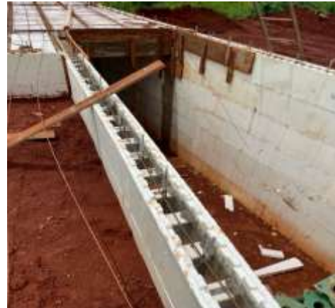
Figura 7-Concretagem das vigas baldrames
