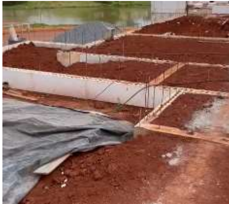
Figura 6-Ancoragens saindo do arranque deixado sob o concreto
