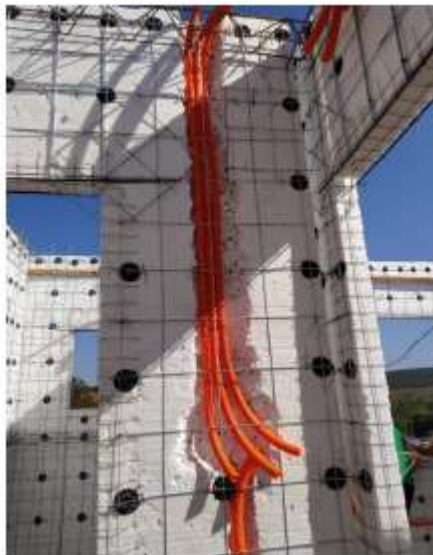
Figura 8-Passagem de conduítes de para execução de elétrica
