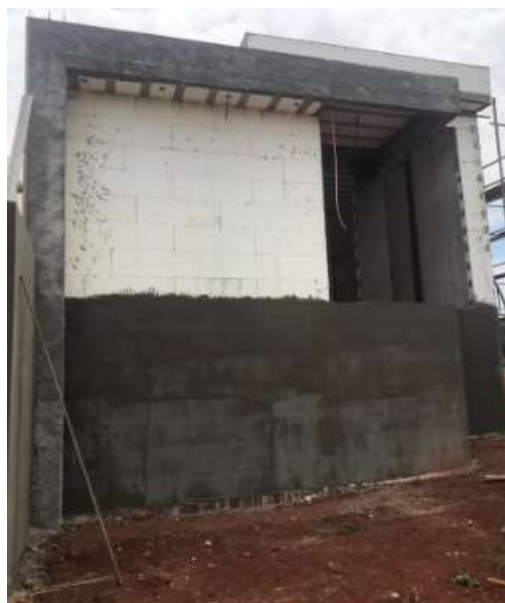
Figura 11-Execução de Reboco da Fachada Principal
