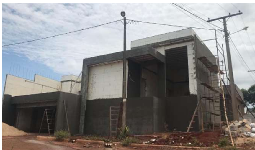
Figura 12-Execução de Reboco
