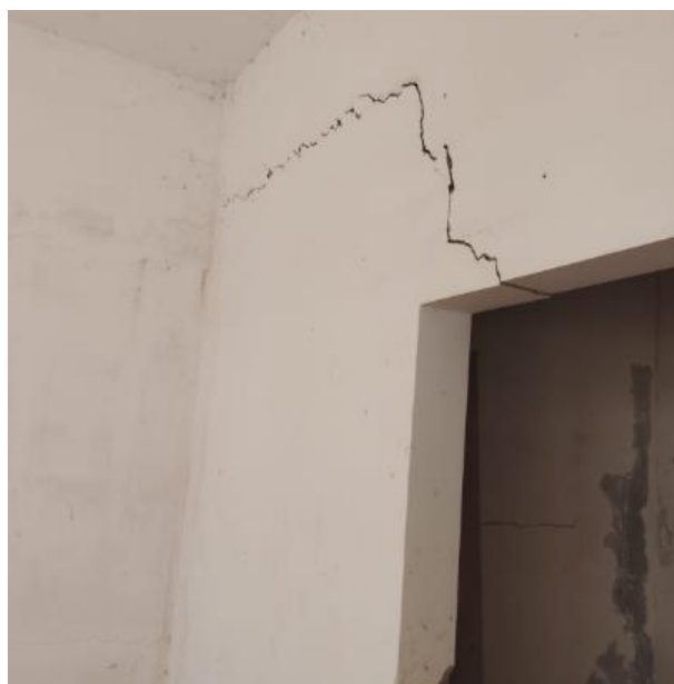
Figura 12 - Rachaduras em aberturas
