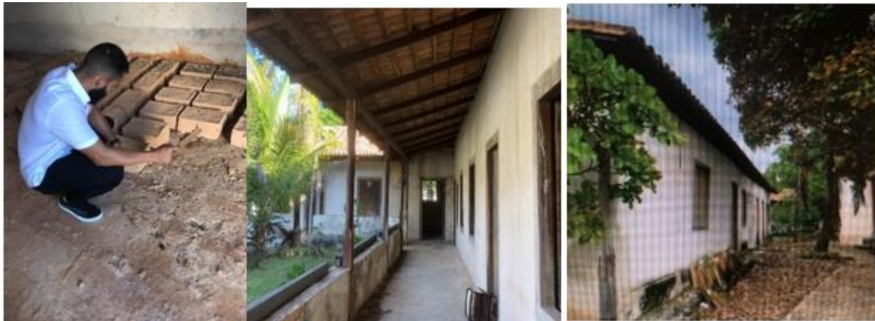
Figura 5 – Visão do acabamento externo e interno do edifício
