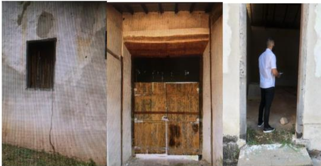
Figura 7- Estado das peças de madeiras das portas e janelas
