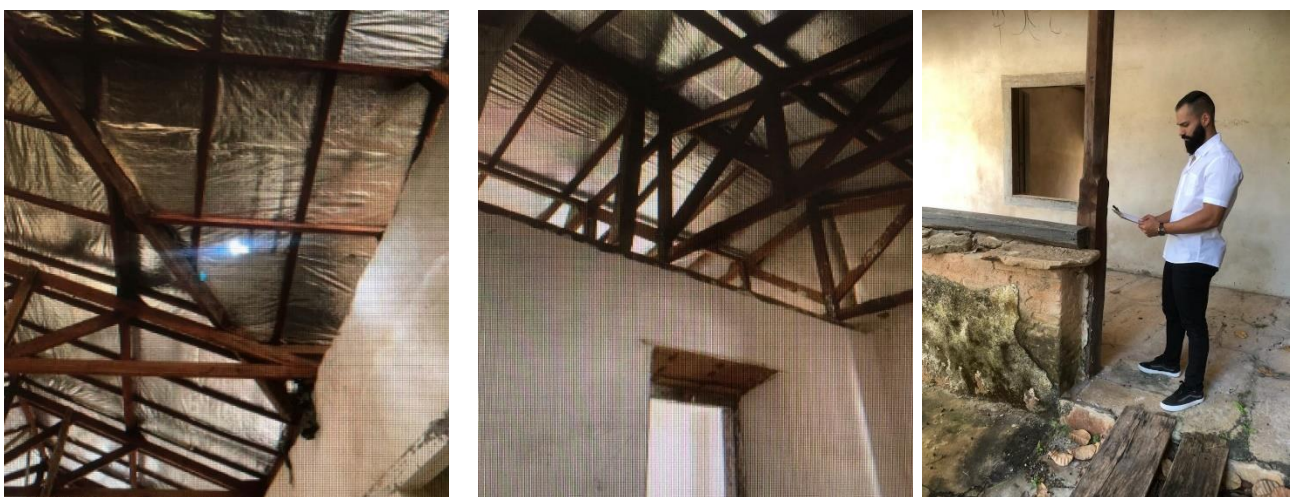
Figura 4 – Sustentação de madeira do edifício
