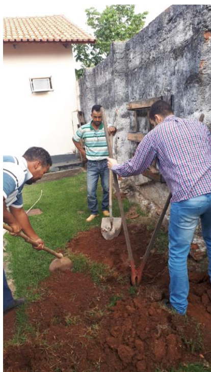
Foto 04 - Construção da composteira em solo
