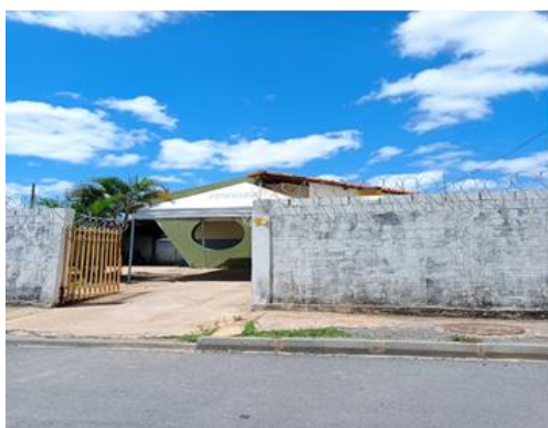
Figura 01: Instalação de Concertina. Fonte: Autor.
