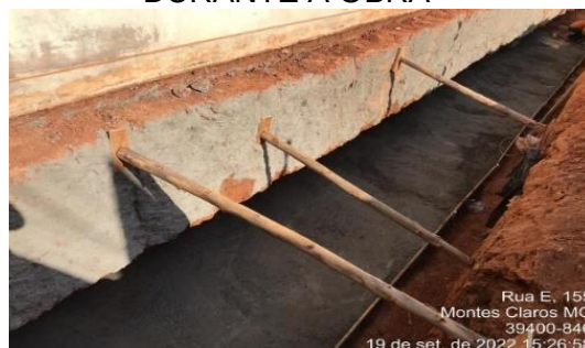
DURANTE A OBRA
