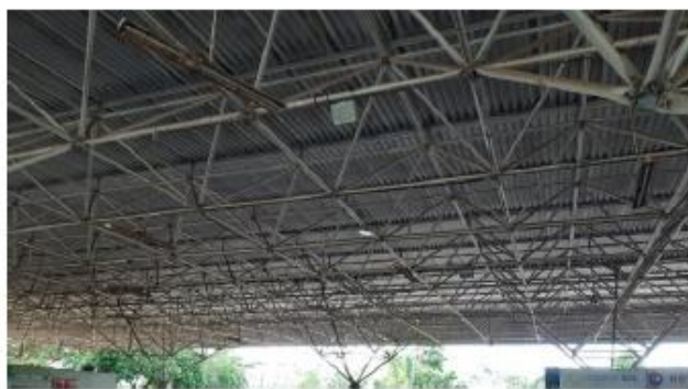
Figuras 5 e 6: Estrutura Tubular oca que compõe o terminal rodoviário de Ipiáú/BA
