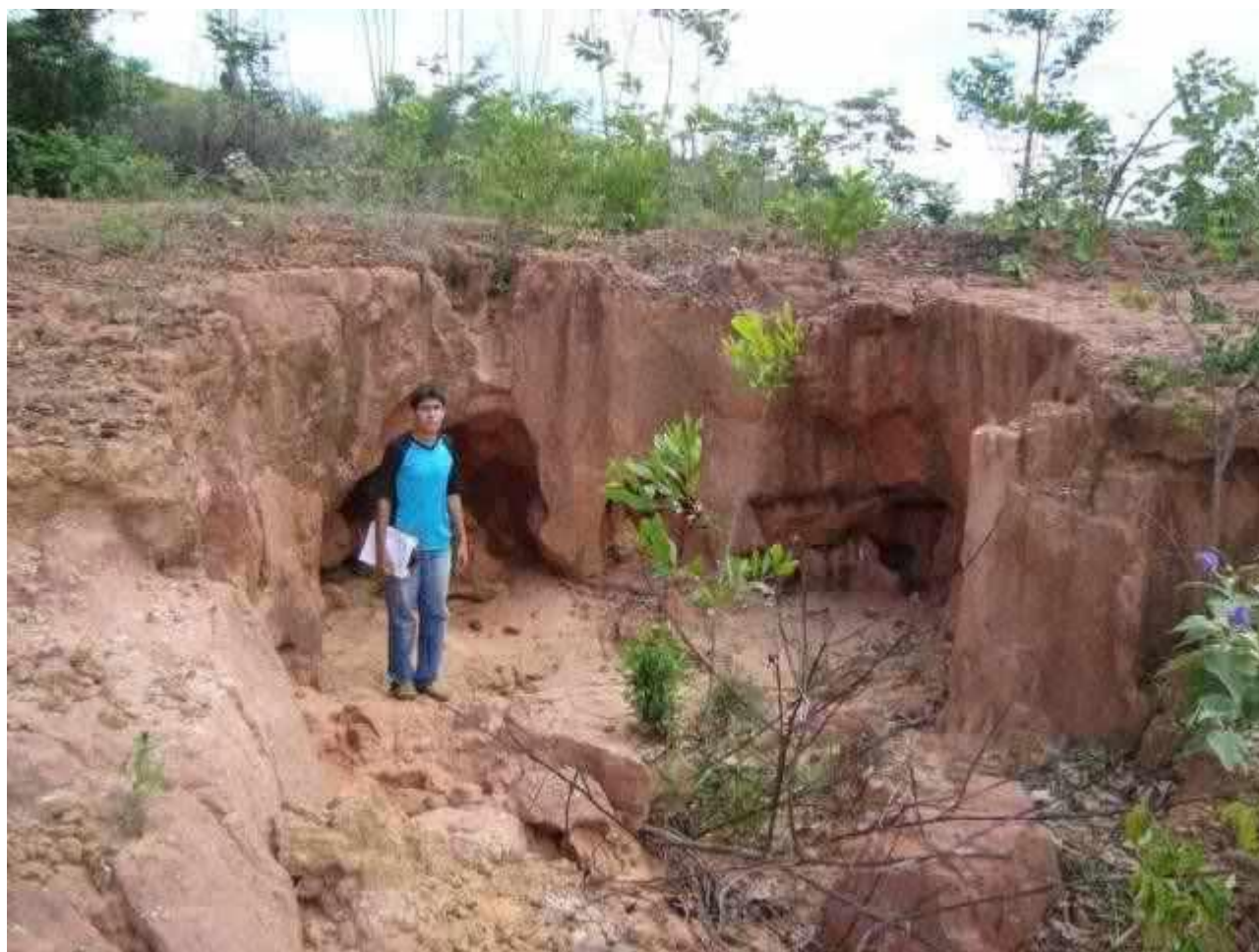
Figura A1.16 - Processos erosivos na antiga área de extração.
