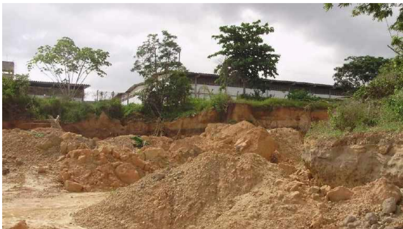
Figura A1.53 - Cava atingindo área Industrial e dando início ao processo erosional.
