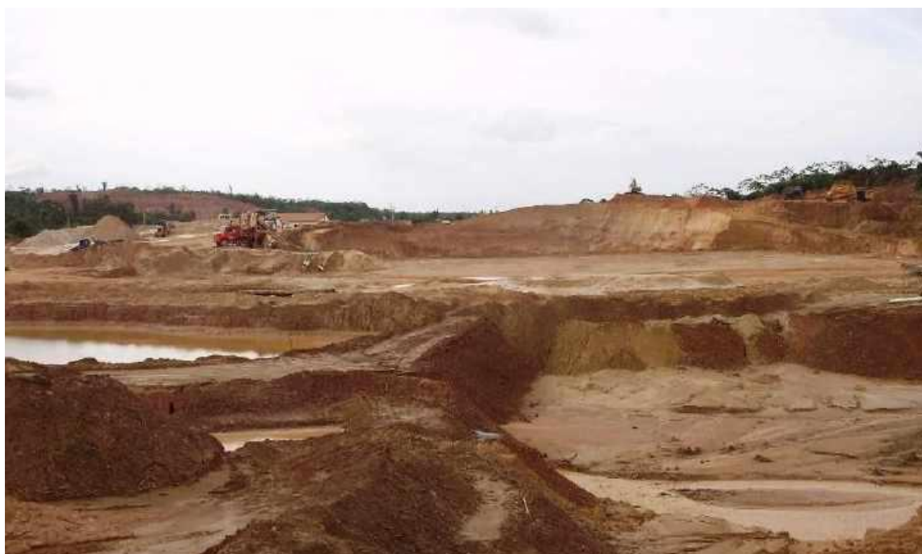
Figura A1.70 - Aspecto geral da escavação sendo a sotoposto ao arenito fino ferruginoso.
