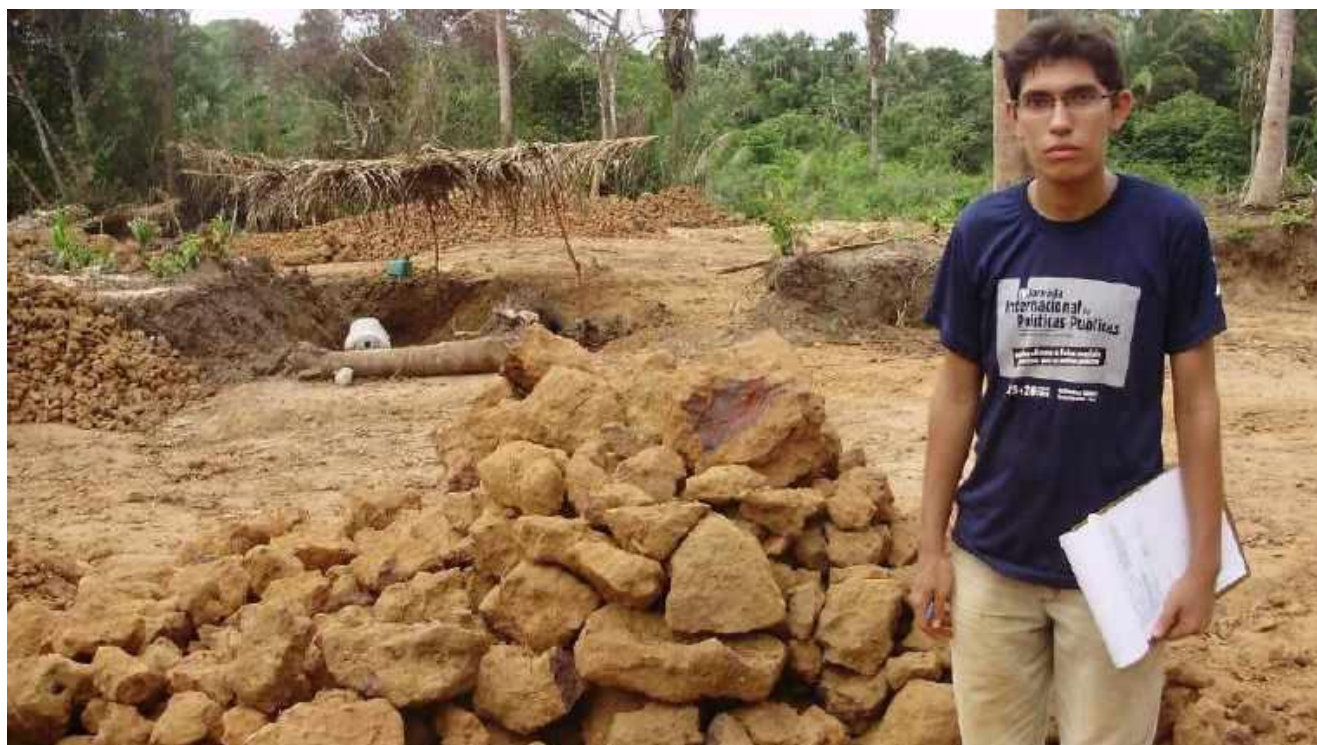
Figura A1.50 - Jazida ativa no bairro Maracanã expondo cava de extração.
