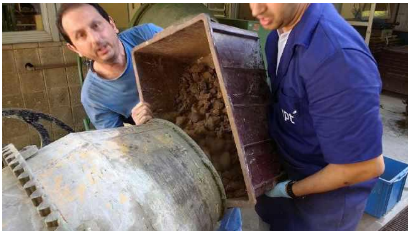
A2.8 - O material citado na foto anterior é lançado na betoneira para primeira homogeneização a seco, após recebe agua na proporção prevista para término da homogeneização.
