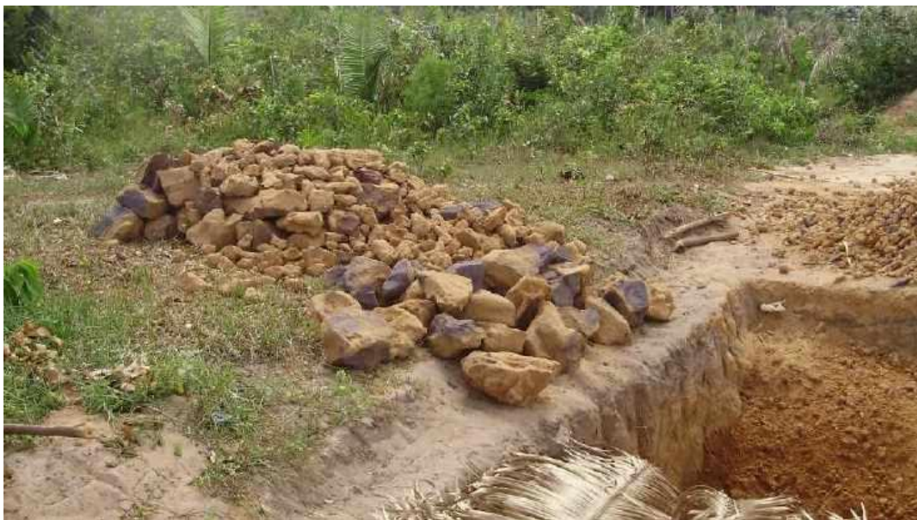
Figura A1.42 - Carrada de lateritas.
