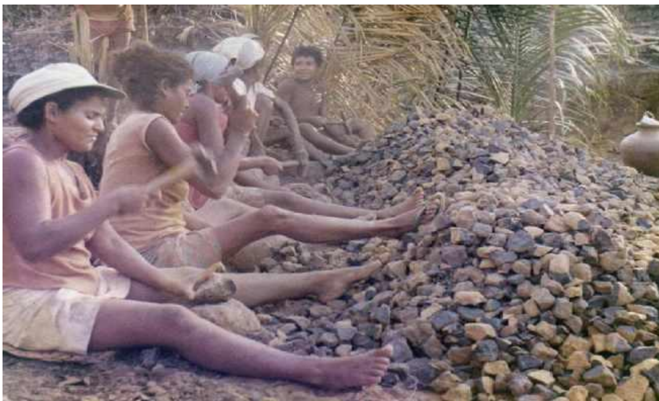
A2.4 - Famílias em que os homens extraem os blocos de laterita e as mulheres e crianças fazem a partição da laterita com auxílio de marreta, batendo o fragmento sobre um bloco de maior tamanho e gerando a brita, que é vendida no mercado da construção civil. Tomada de foto registrada no ano de 1976.
