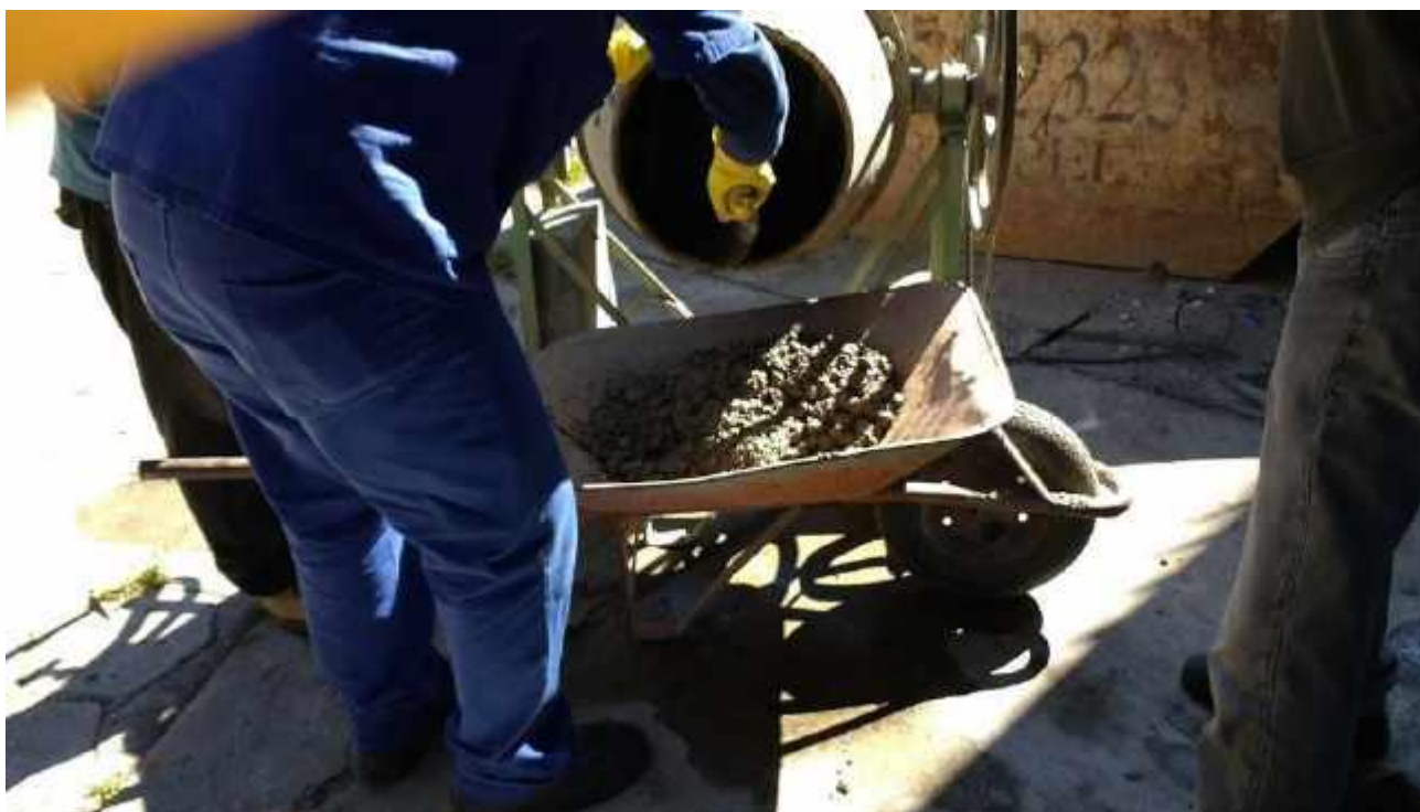
A2.10 - Após homogeneização o concreto é lançado num carrinho de mão, sendo posteriormente transportado para pertinente moldagem dos corpos de prova.
