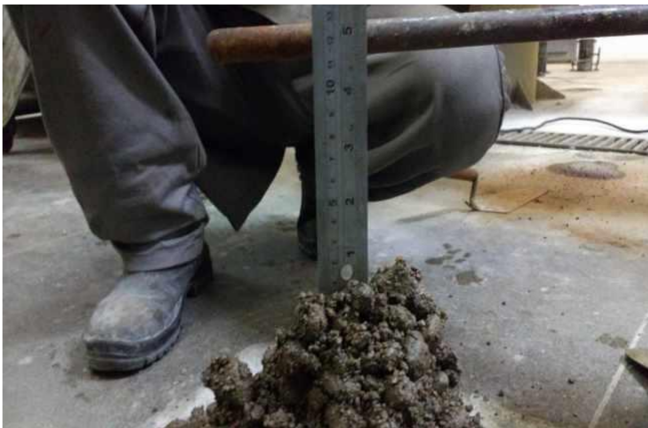
A2.14 - Ensaio de Slump Teste apresentando o abatimento que foi obtido após a deformatação do corpo de prova. Neste caso o concreto apresenta abatimento de mais de 10 cm, quando desformatado, revelando possuir trabalhabilidade. Diferente do concreto apresentado na foto anterior em que permaneceu sem qualquer abatimento.
