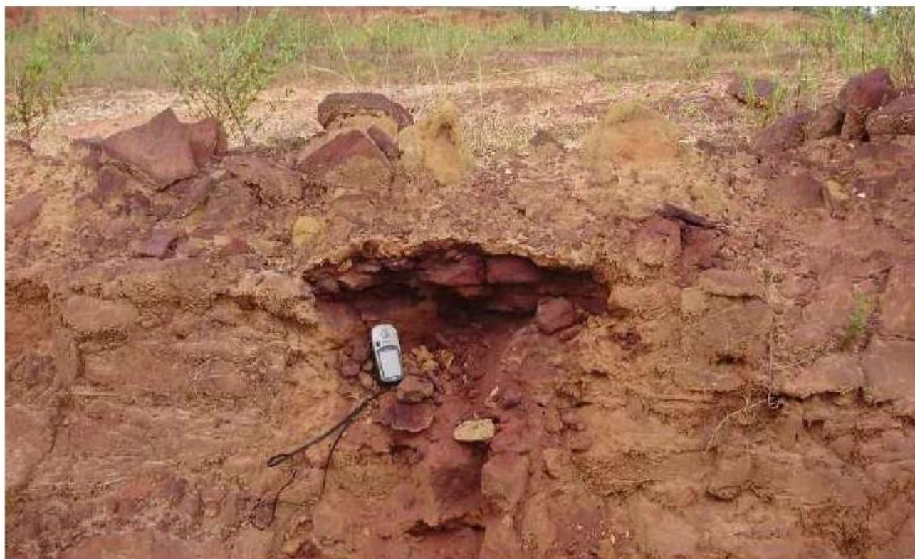
Figura A1.60 - Arenito estratificado em processo de laterização.
