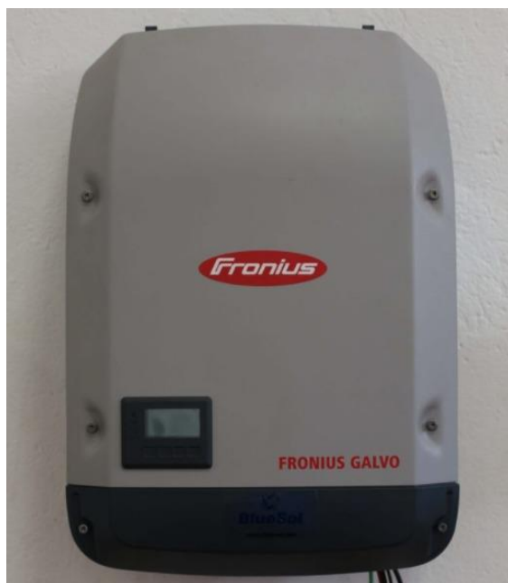
Figura 3- Inversor para sistema FV
