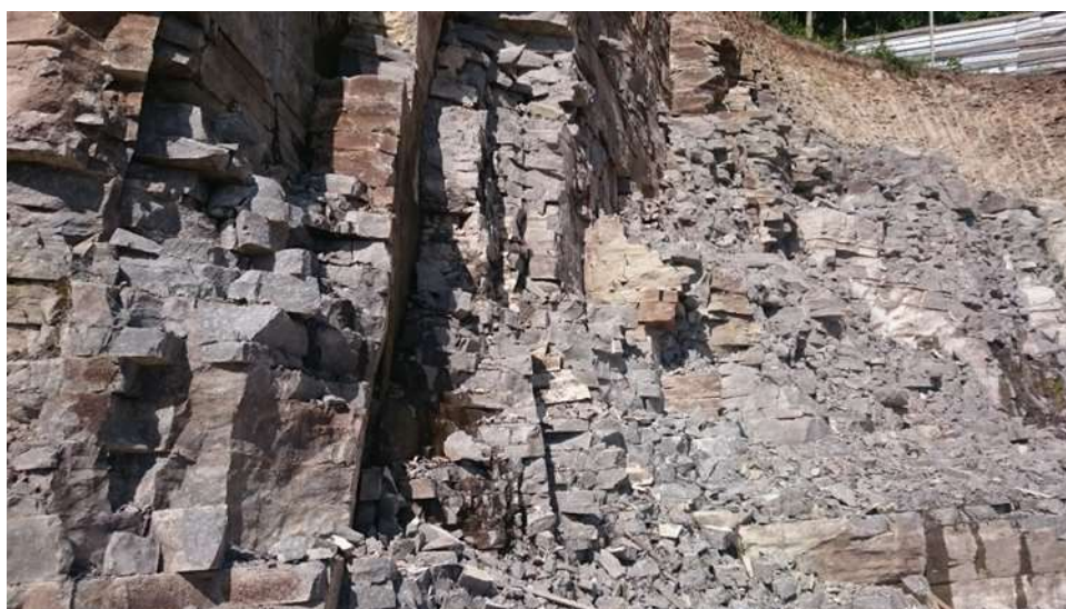
Figura 5 - Visada para oeste da porção oeste do Talude 3 em sentido perpendicular a família de descontinuidades F2. A imagem mostra evidências de queda de blocos.
