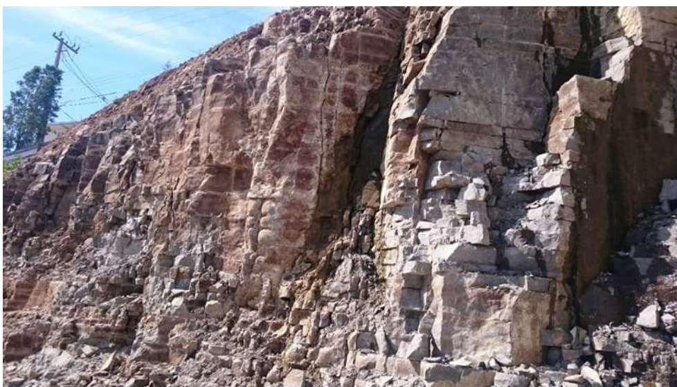
Figura 5 - Visada para oeste da porção oeste do Talude 3 em sentido perpendicular a família de descontinuidades F2. A imagem mostra evidências de queda de blocos.
