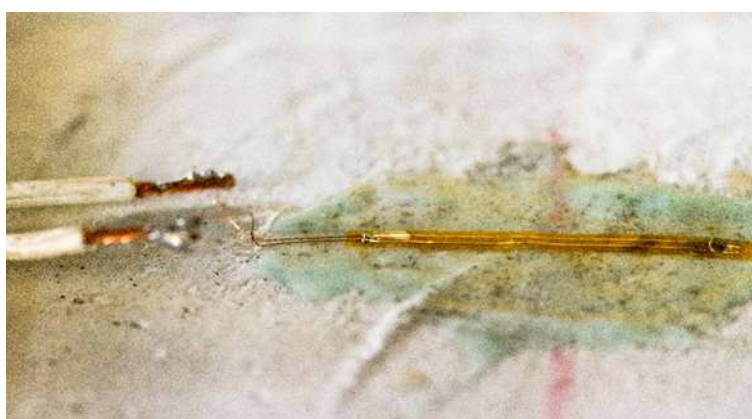
Figura 7– Detalhe do extensômetro do concreto
