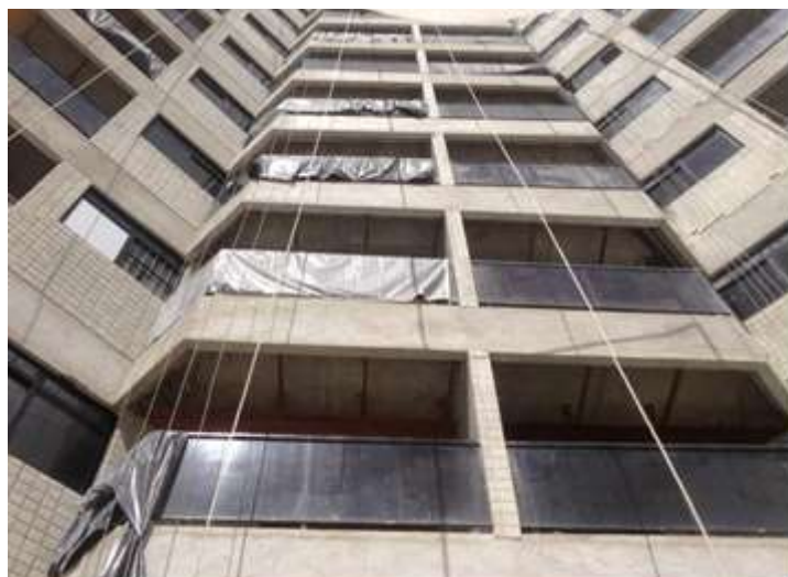
Figura 9 – Execução do novo emboço das vigas da fachada
