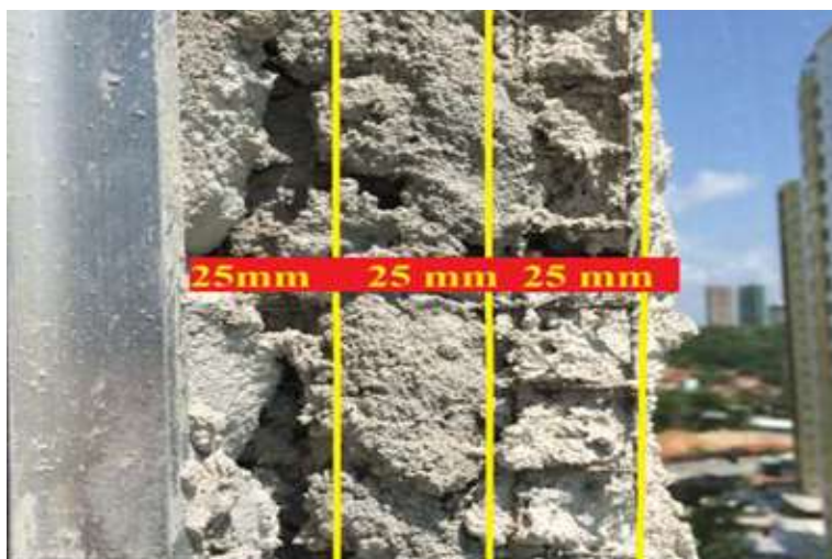
Figura 10 – Execução do novo emboço das vigas da fachada
