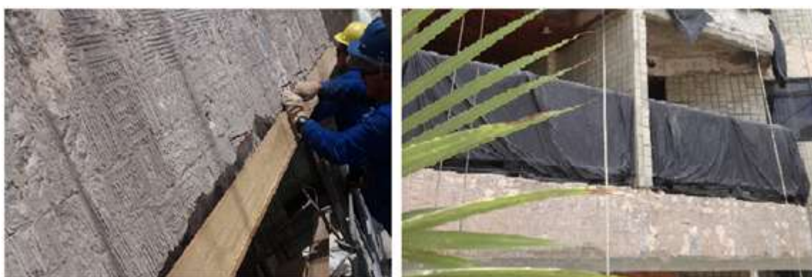
Figura 14 – Execução da pingadeira removida
