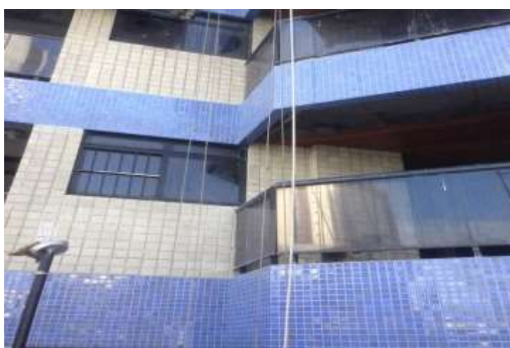
Figura 11 – Execução do novo revestimento cerâmico das vigas da fachada
