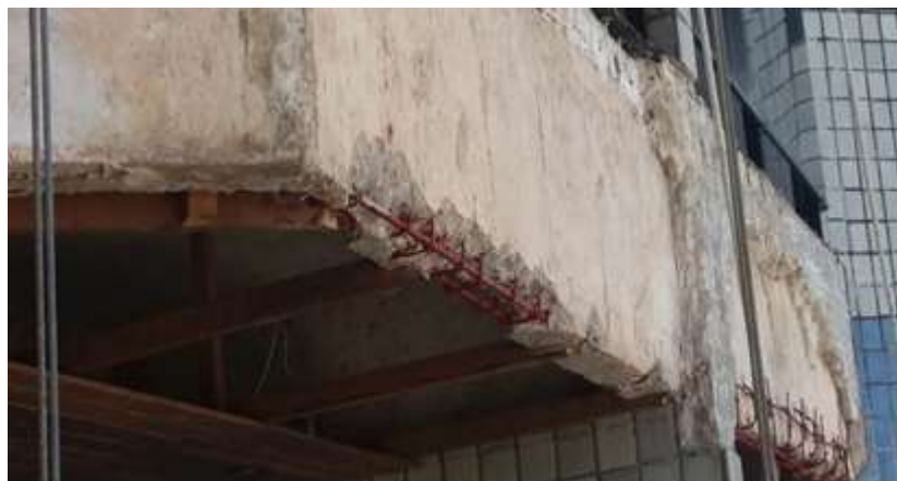
Figura 13 – Tratamento da armadura da viga com inibidor anticorrosivo
