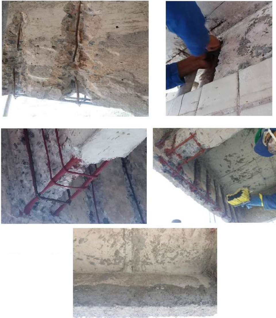
Figura 7 – Sequência de recuperação das armadura com apicoamento, lixamento, reposição da armadura, aplicação de primer anticorrosivo e reconstituição da seção de concreto.
