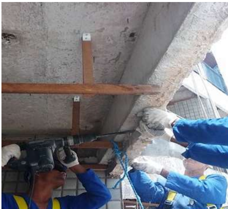
Figura 12 – Remoção das pingadeiras da viga da varanda
