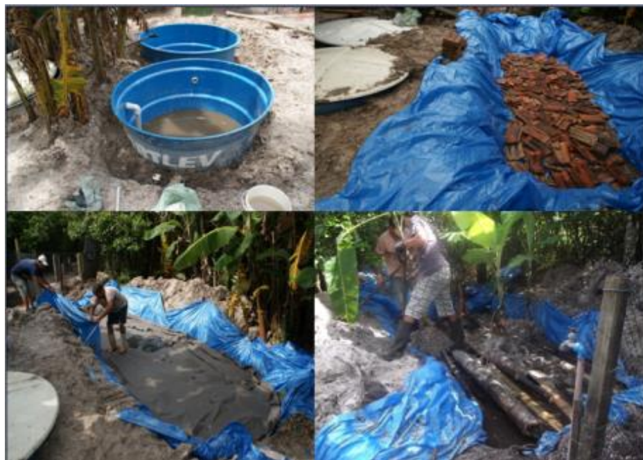
Figura 7 - Sistema de esgoto em estágio de montagem.
