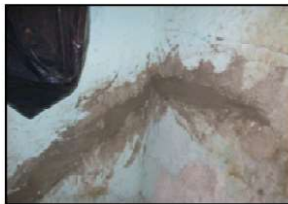
Figura 6 - Reparo na parede
