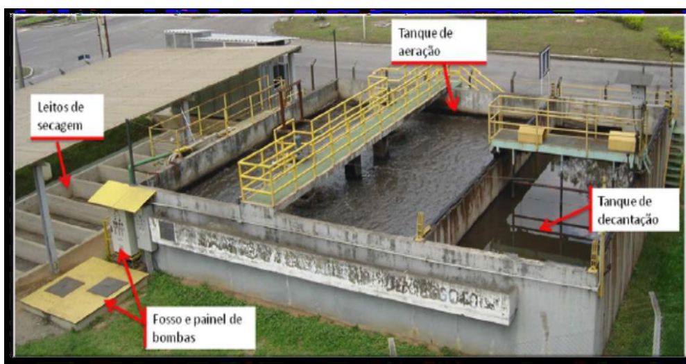
Figura 8 – Estação de tratamento de esgoto
