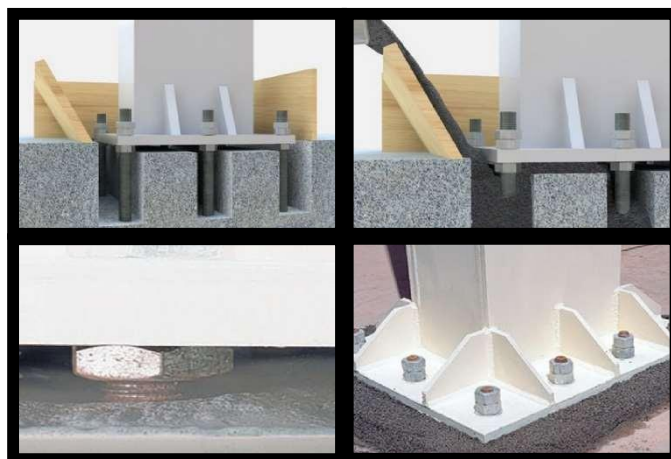
Figura 3: Ancoragem pré-instalada - “Grauteamento”
