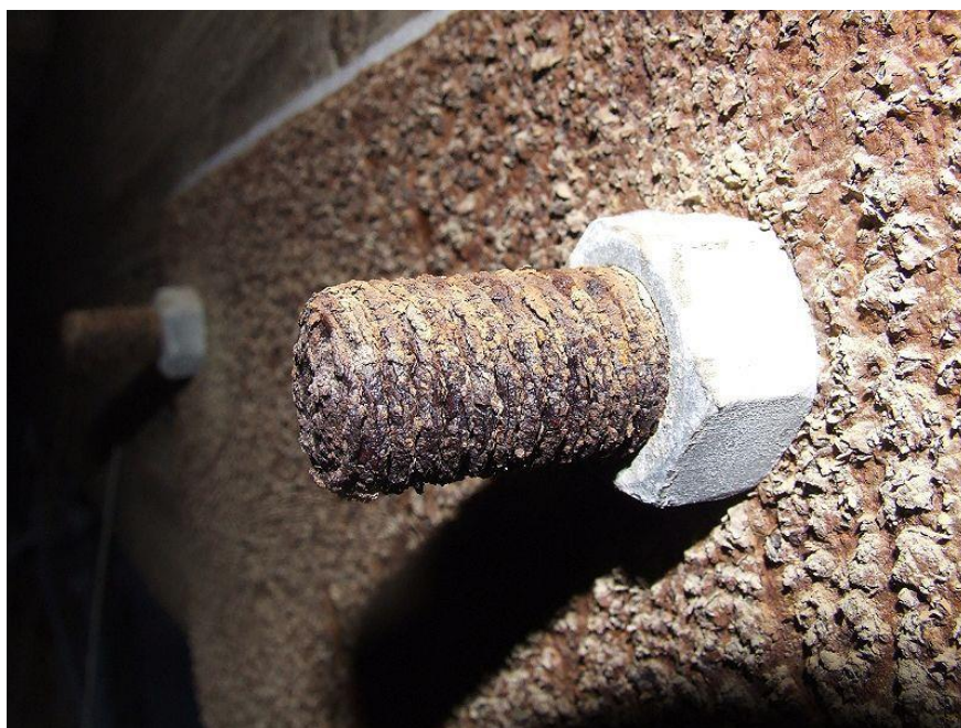
Figura 16 - Corrosão localizada.
