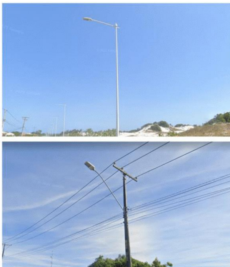
Figura 10. Montagem de luminária na Av. Mão Stella de Oxóssi
