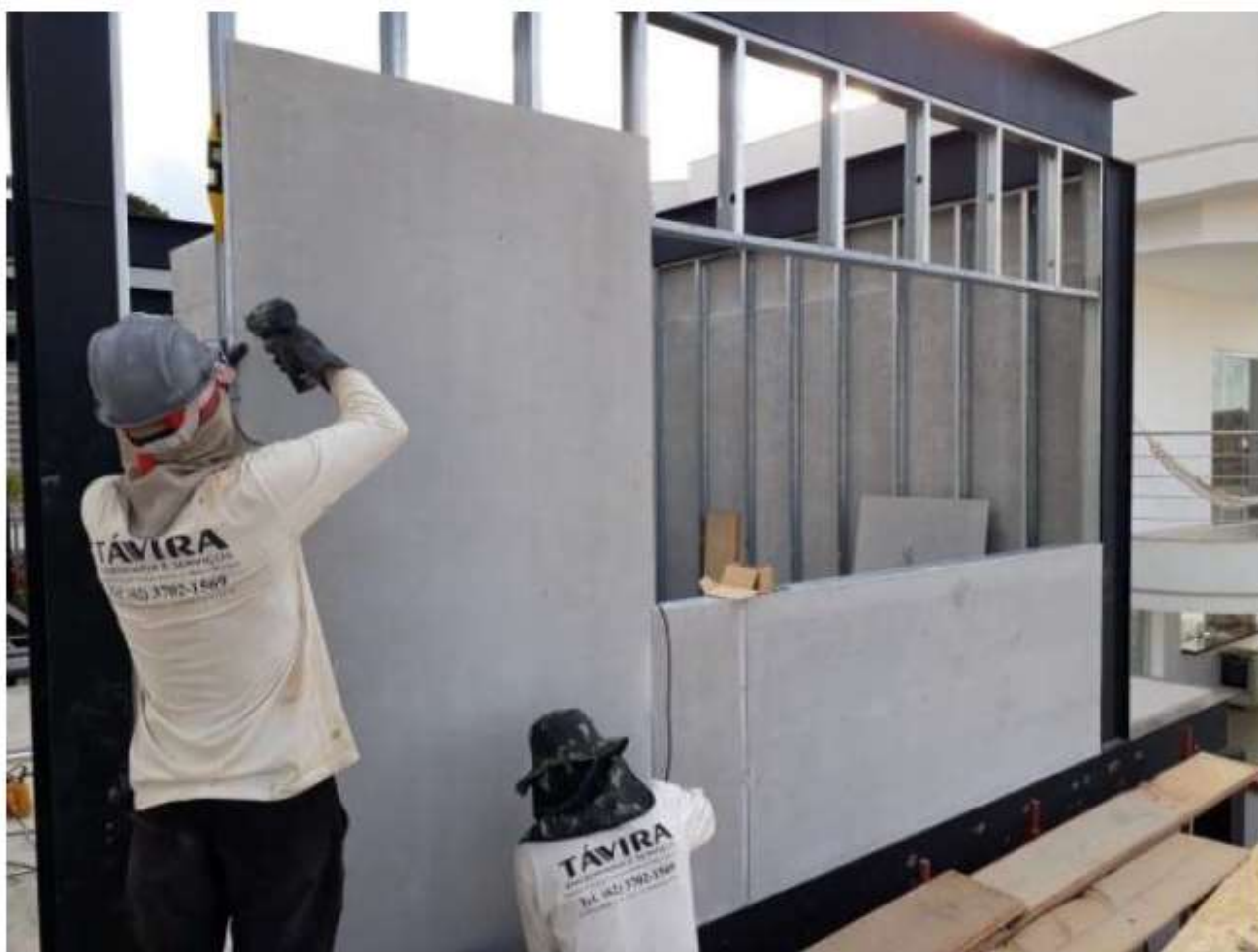
Figura 3: Placas Cimentícias em sistema Steel Frame
