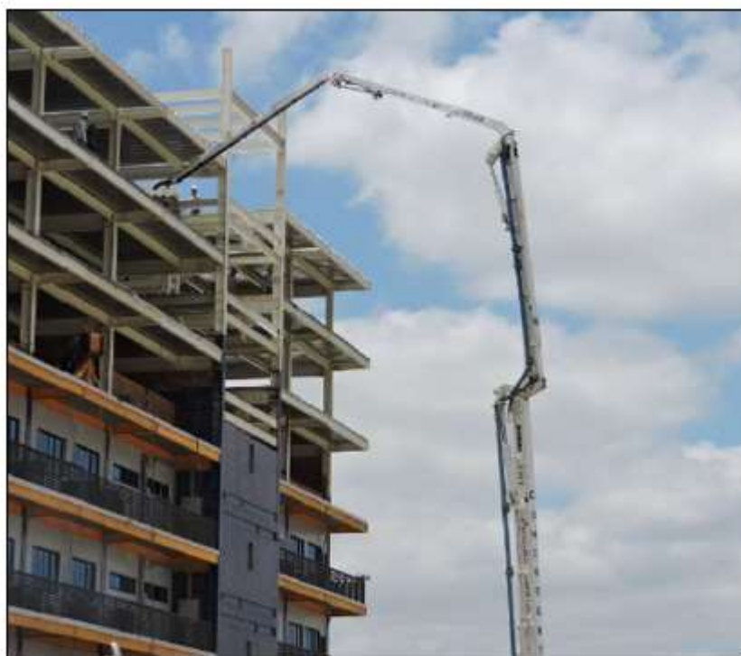
Figura 10 - Concretagem nova unidade faculdade Maurício de Nassau
