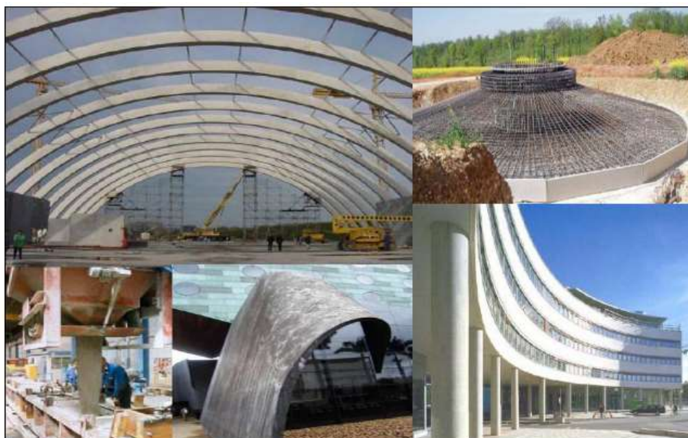
Figura 7 - Utilização e aplicação do Auto Adensável
