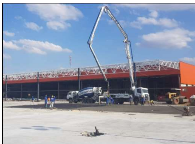
Figura 11 - Obras da Unidade do Atacadão Caruaru
