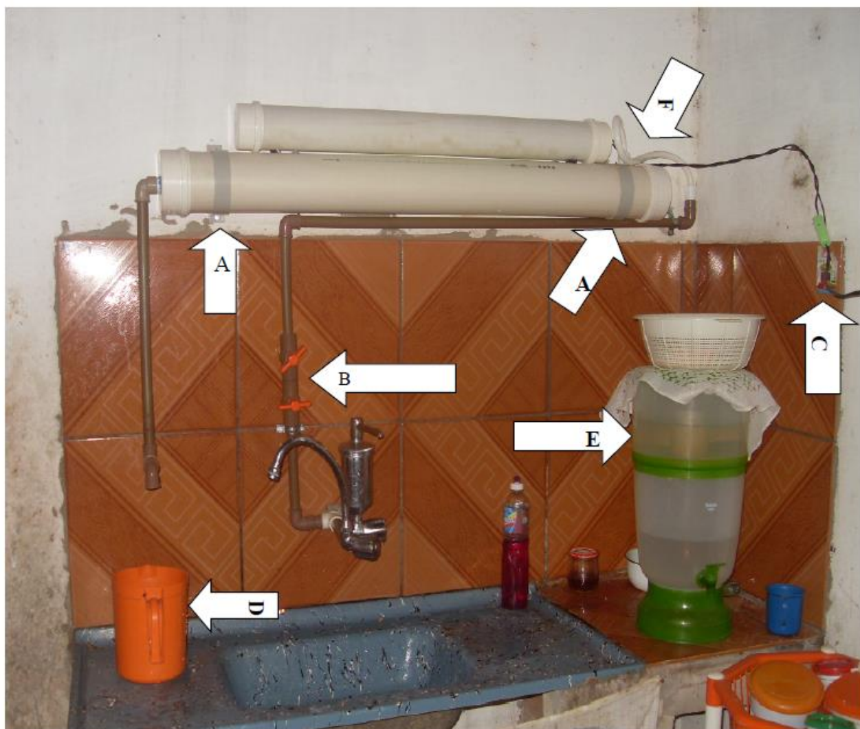
Figura 40 – Imagens do Tubo UV instalado na residência do Sr. Gilvan, localizada no assentamento rural Boa Esperança, amostrando as adaptações necessárias para instalação do Tubo de acordo com seguinte a legenda: (A) Abraçadeiras para fixação com 04 parafusos e buchas, (B) Registro de controle de vazão da água para ideal radiação UV, (C) Fiação elétrica e interruptor acionador da lâmpada UV, (D) Recipiente para coleta de água tratada, (E) Recipiente para guarda da água tratada e (F) Tubo de ligação flexível plástico. Zé Doca, Maranhão, Brasil.
