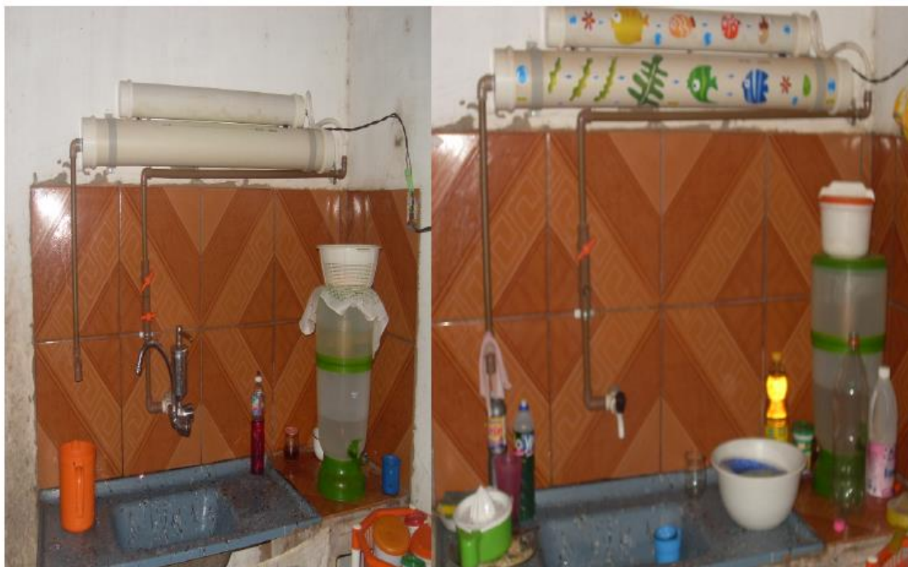
Figura 44 – Imagem do Tubo UV quando recém instalado na residência do Sr. Gilvan e a direita imagem do mesmo equipamento visualizada, em visita posterior, demonstrando a adesivagem realizada para embelezamento do equipamento e percebendo-se aceitação do tratamento de água proposto aos moradores do assentamento rural Boa Esperança, Zé Doca, Maranhão, Brasil.
