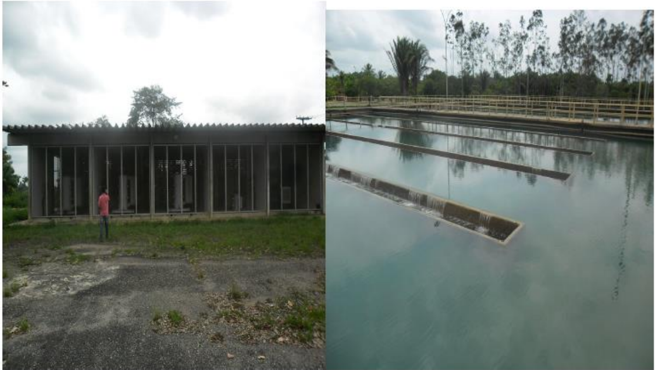
Figura 25 – Imagem da casa de força responsável em suprir a enorme demanda de energia elétrica para movimentação dos equipamentos elétricos da ETA-Italuis e dos últimos tanques de separação onde já supostamente se encontra água indicada para uso, sendo necessária esta confirmação em teste de laboratório para liberação da água para o duto de distribuição que percorre 56 km até São Luís, Maranhão, Brasil.
