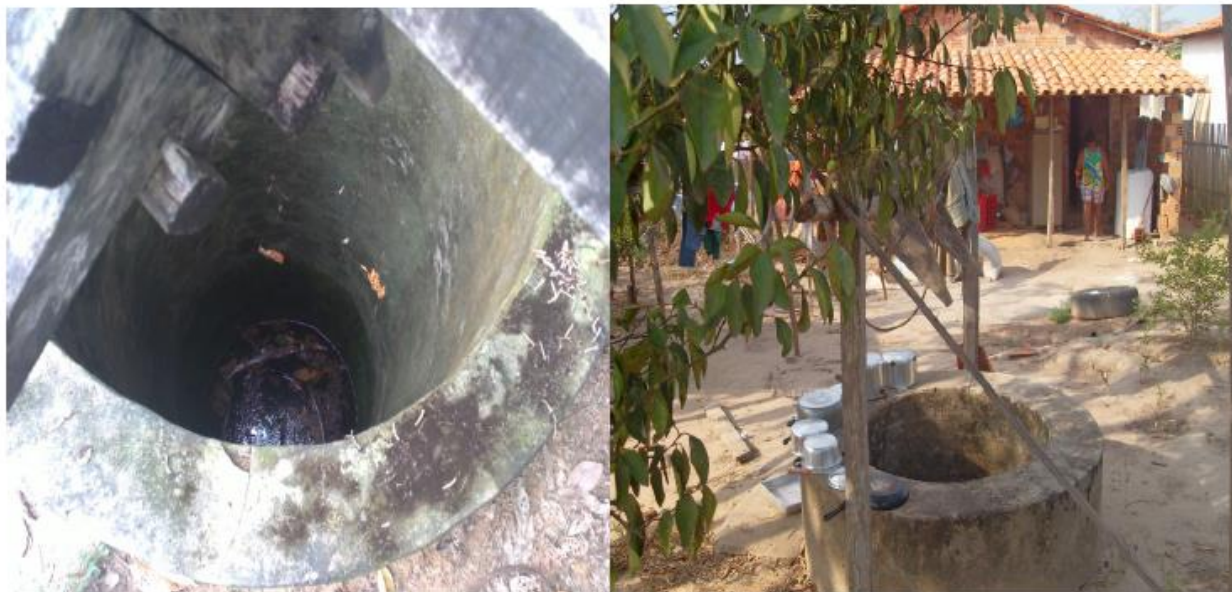
Figura 16 – Fontes de água do assentamento rural Boa Esperança, destacando-se a lavagem de vasilhames na bordadura e a presença de folhas e materiais estranhos no interior do poço cacimbão em uso. Zé Doca, Maranhão
