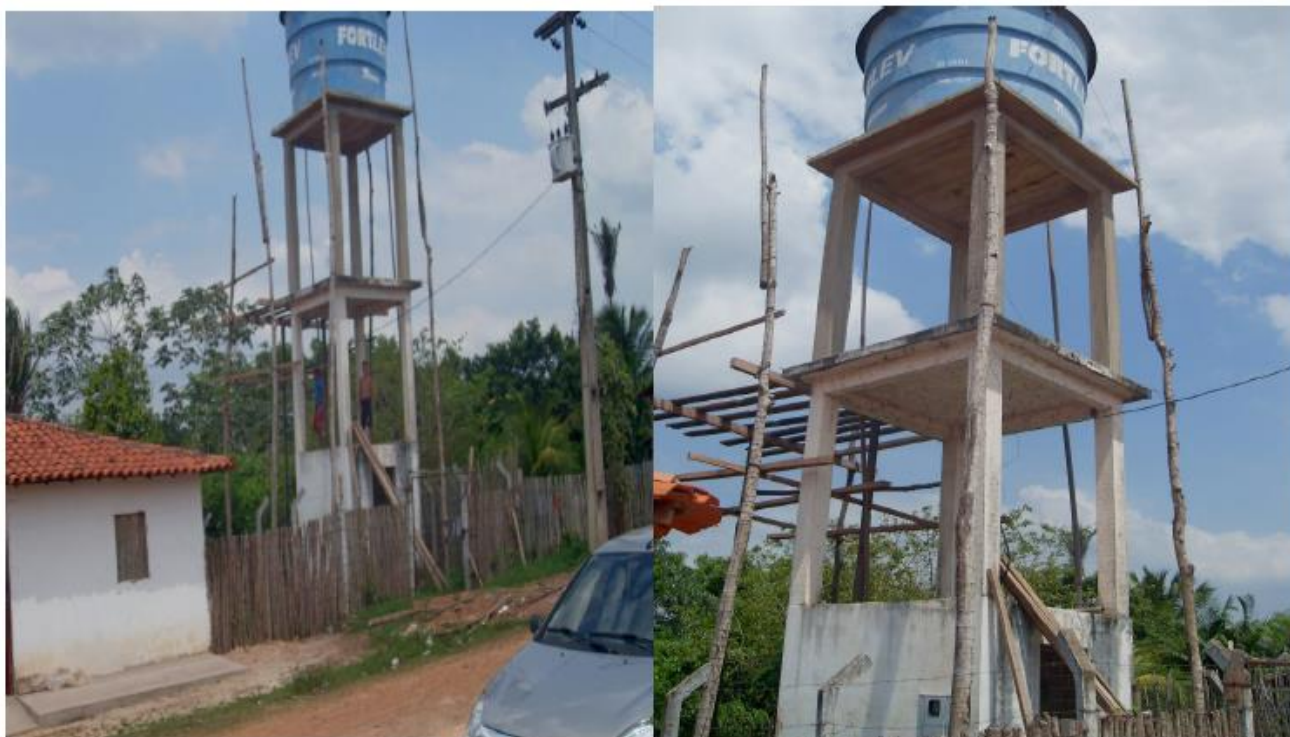
Figura 47 – Imagem atual da área do reservatório de água do assentamento rural Boa Esperança, Zé Doca, Brasil, mostrando a reforma em andamento, inclusive com feitiço complementar de cerca de madeira que foi construída para evitar a presença de animais que antes circulavam normalmente no interior do sistema que possuía apenas cerca de poste de concreto.
