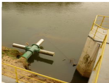
Figura 2. Crepina, aparelho responsável pela captação da água.
