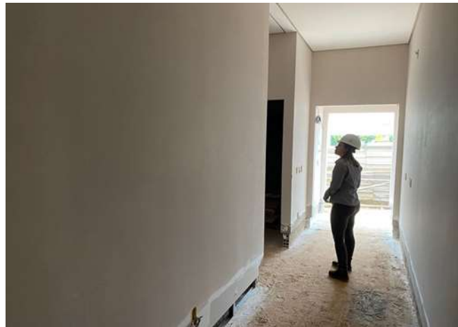
Figura 9- Parede de Drywall Finalizada
