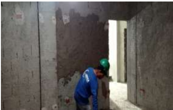
Figura 3 fase do reboco
