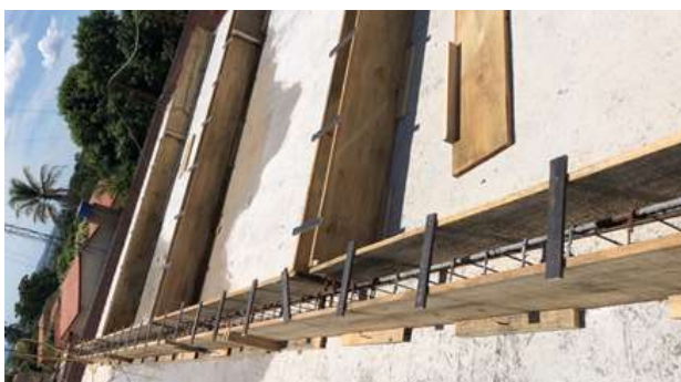
Figura 9- Fôrmas das Vigas de Cobertura
