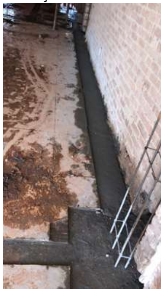
Figura 7- Concretagem Da Fundação
