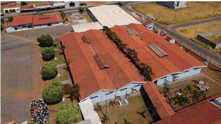
Figura 9 – Foto Telhado Existente (2012)
