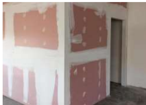
Figura 6 Parede de Drywall fechada
