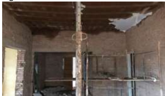
Figura 4- Retirada do reboco
