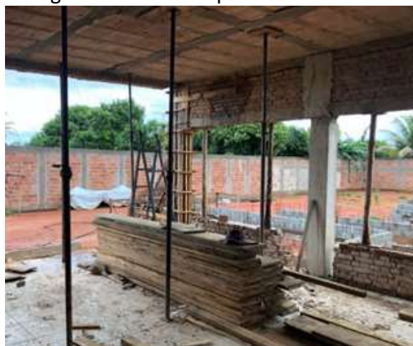
Figura 11- Retirada parcial das escoras
