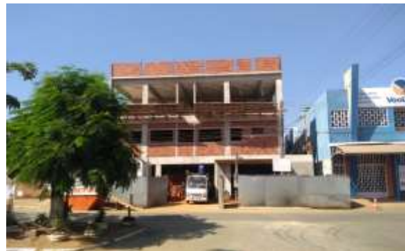
Figura 4 Alvenaria quase finalizada
