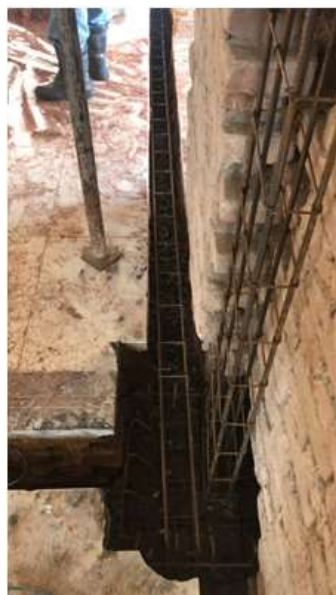
Figura 6- Confeção De Sapatas E Vigas Baldrame
