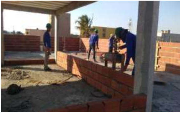
Figura 1- Assentamento da Alvenaria
