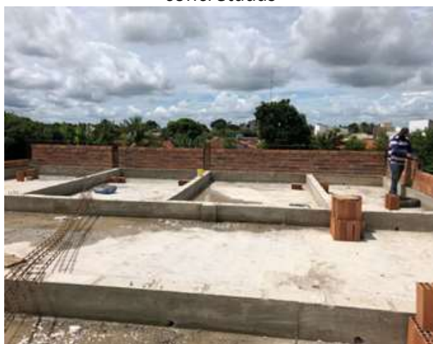
Figura 10- Vigas de Cobertura e laje concretadas
