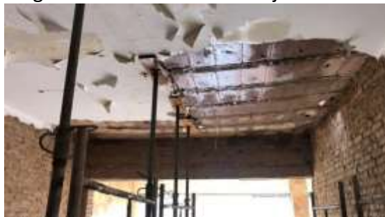
Figura 3- Escoramento da Laje
