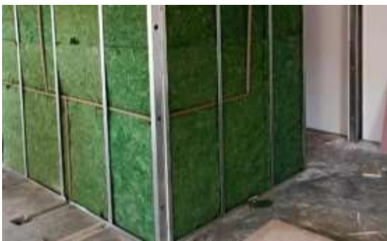
Figura 5 Processo de Instalação da Lã de Rocha
