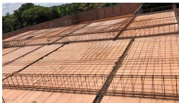
Figura 8- Armação do concreto da laje
