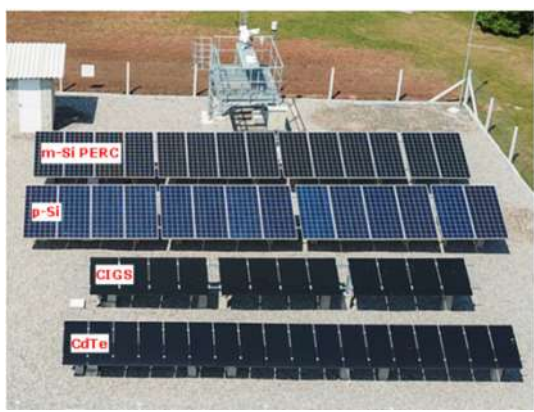
Figura 1 – Visão aérea da EPESOL-CT.
