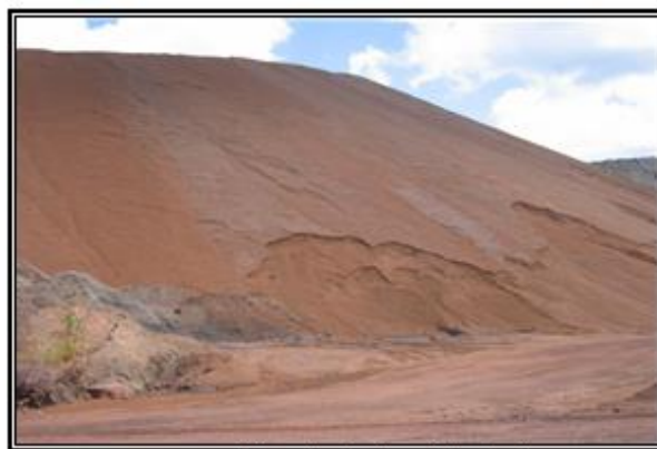
Pilha de rejeito sinter feed
