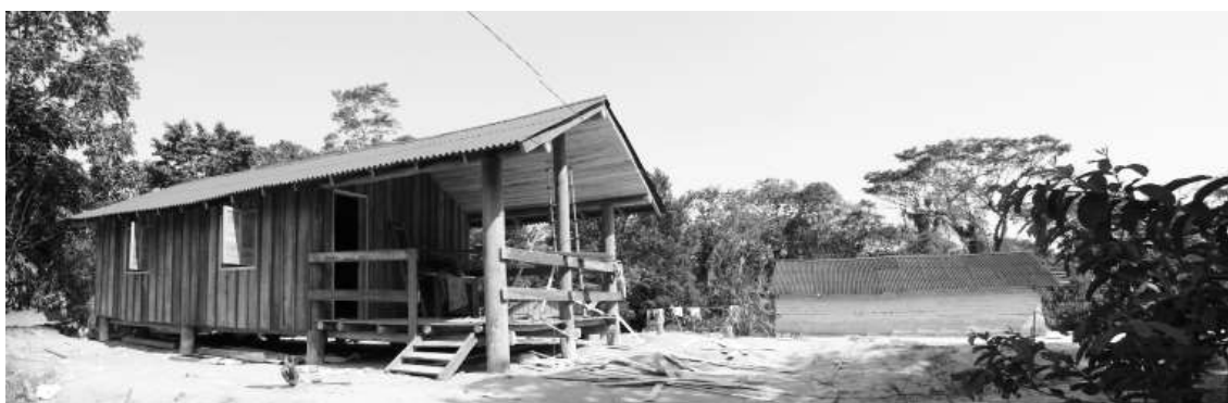
fig. 5 – Casa Elevada concluída.
