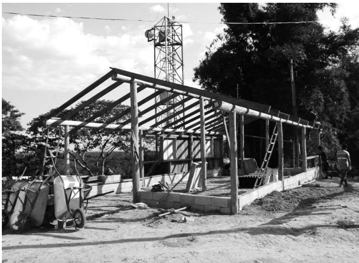
fig. 4– Casa Térrea em construção por mutirão.
