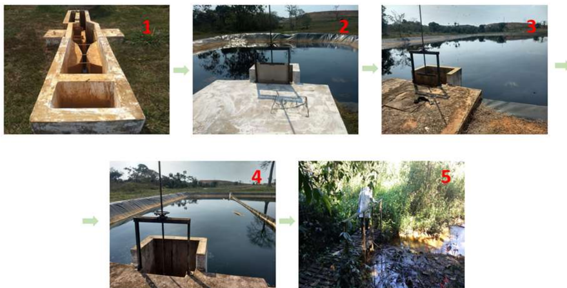
Figura 2. Locais de coleta de amostras do lixiviado da Unidade de Tratamento de Resíduos Sólidos em Rio Branco, Acre, Brasil. 1. Calha Parshall; 2. Lagoa anaeróbica; 3. Lagoa facultativa; 4. Lagoa de maturação; 5. Zona de mistura.
