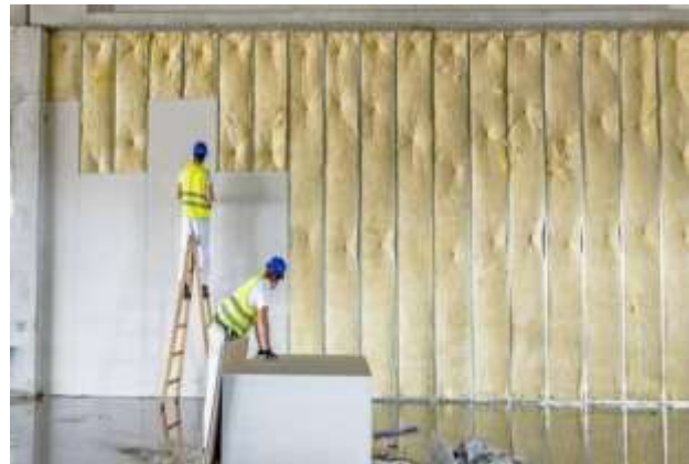
Figura 6-Isolamento executado com lã de vidro Fonte: AECweb.
