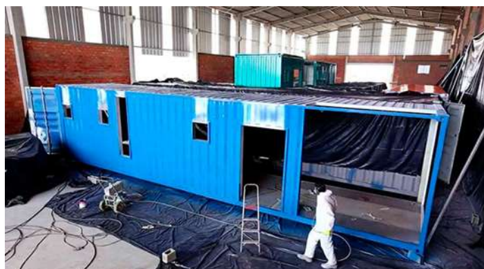
Figura 5-Alterações sendo realizadas em contêiner
