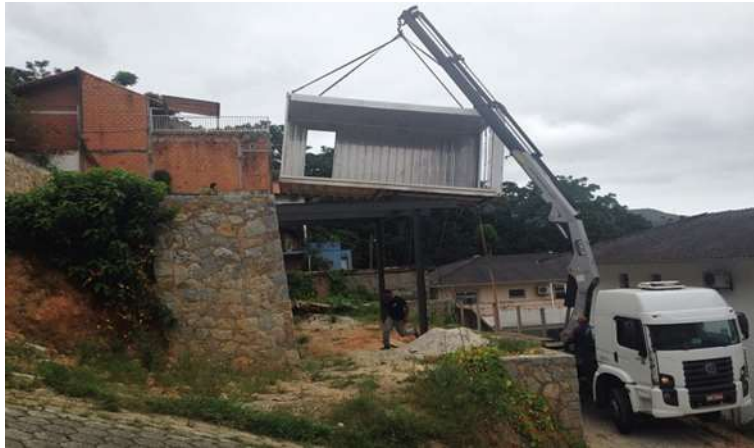
Figura 10-Caminhão munk posicionando casa contêiner
