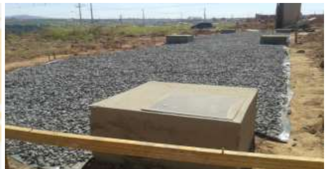
Figura 8-Sapata da fundação para casa contêiner Fonte - Vem Casinha
