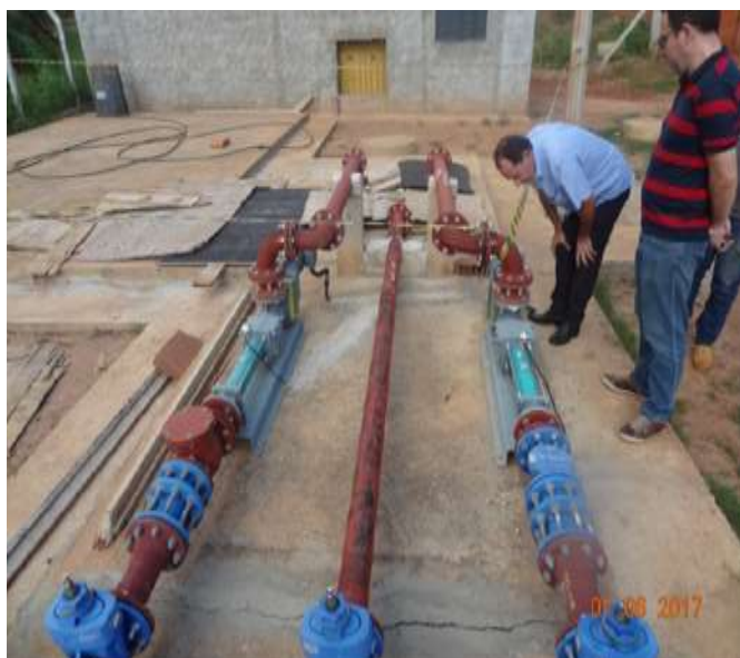
Figura 7 – Construção de nova EEE (estação elevatória de esgoto).
