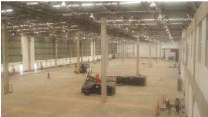
Figura 2- Galpão de 9000m 2
