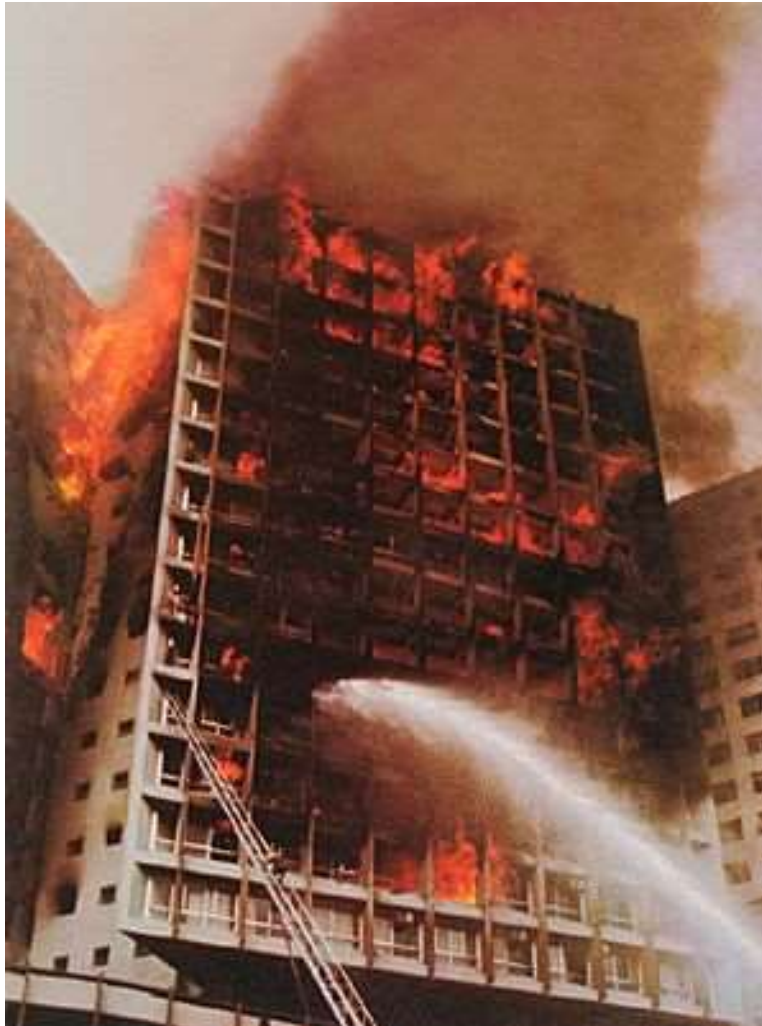
Figura 23 – Incêndio no Edifício Joelma.
