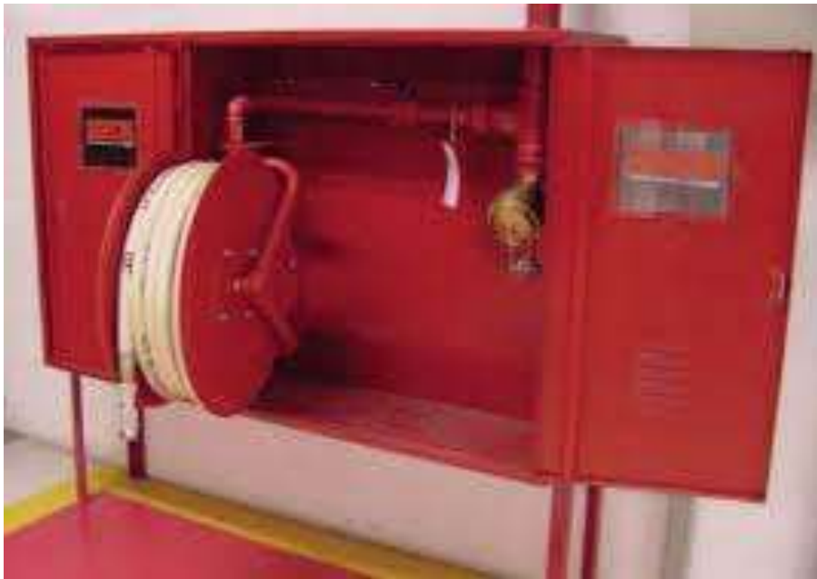
Figura 17 – Sistema de mangotinho.
