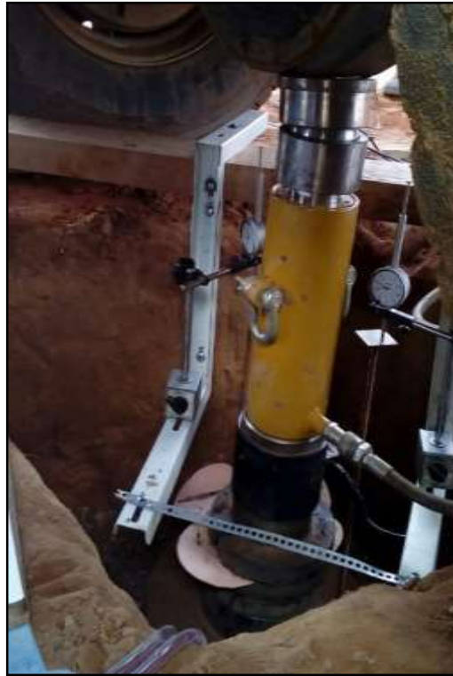
Figura 2. Prova de Carga em Estaca (Gonçalves et al., 2018).
