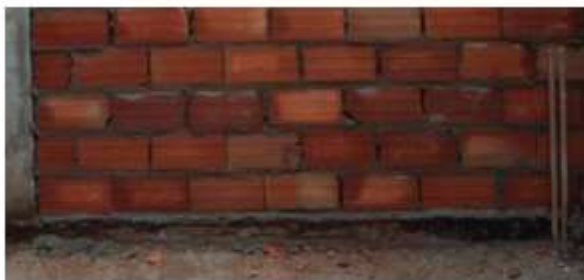
Figura 2- Alvenaria de Bloco Cerâmico. Fonte: Própria, 2021.
