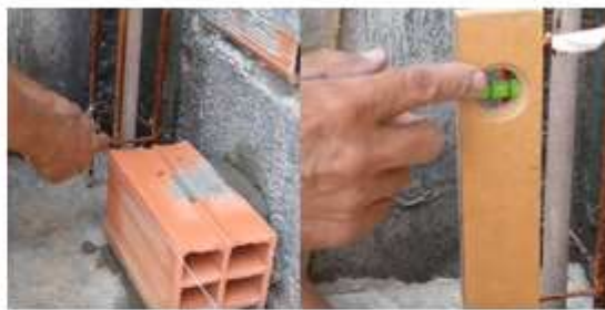
Figura 3- Levantamento de Alvenaria tradicional Fonte: Própria, 2021.
