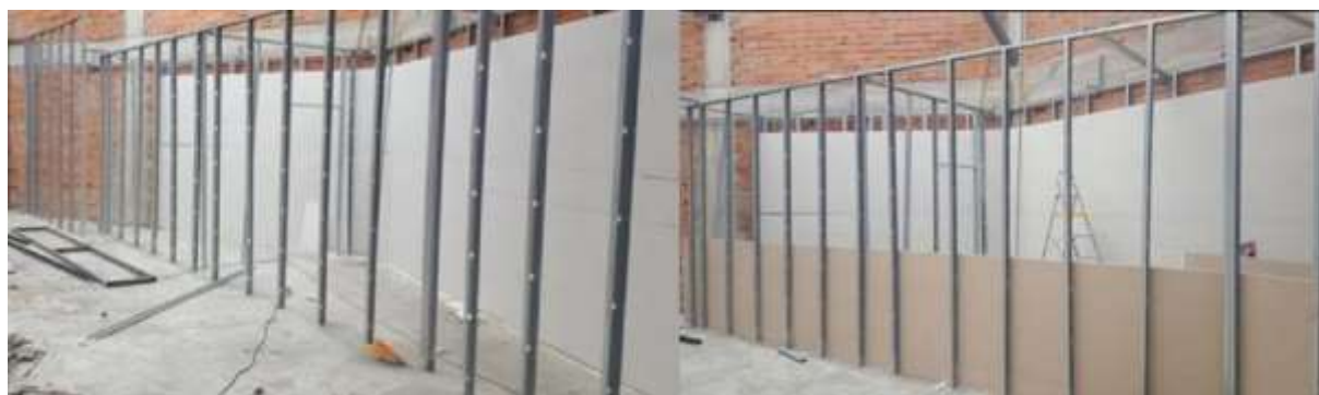
Figura 8- Instalação dos montantes
