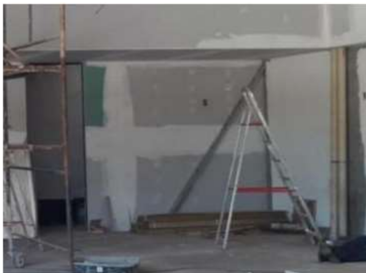
Figura 13- Aplicação de fita com massa Fonte: Própria, 2021.
