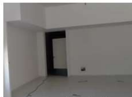
Figura 15- Parede finalizada com Pintura
