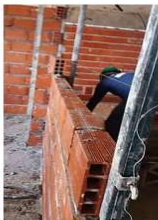
Figura 4-Detalhe de equipamentos e etapa da elevação de alvenaria Fonte: Própria, 2021.
