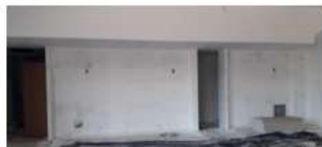
Figura 14- Aplicação de massa de nivelamento Fonte: Própria, 2021.
