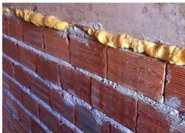
Figura 5-Encunhamento com Poliuretano. Fonte: Própria, 2021.
