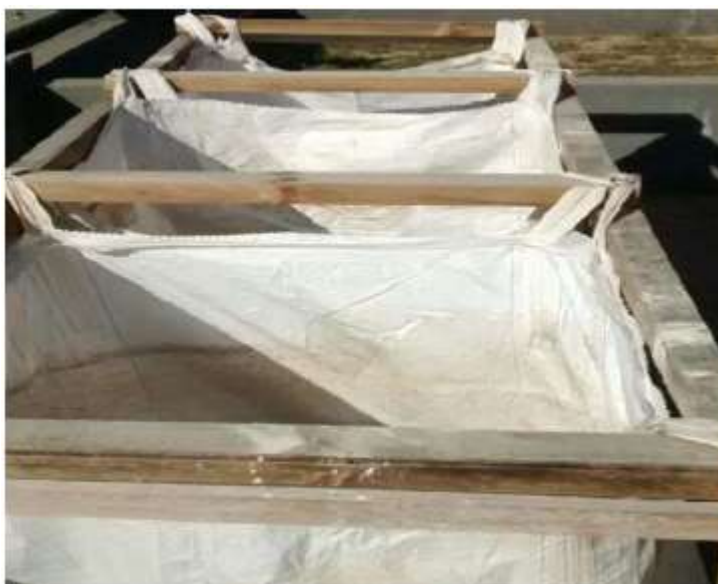
Figura 2 – Big Bags instalados sobre o leito de secagem (estruturas em madeira iniciadas para ensaio)
