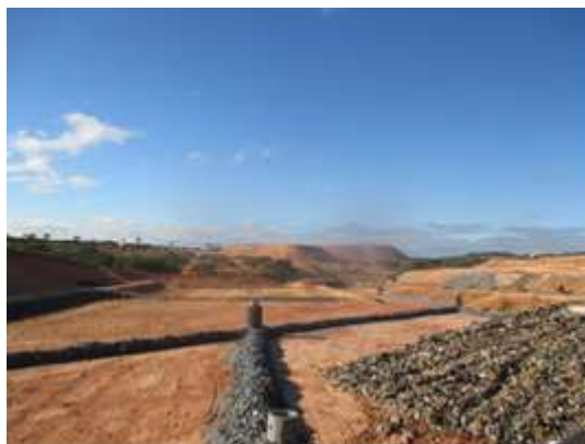
Figura 5a - Intercepção dos drenos
