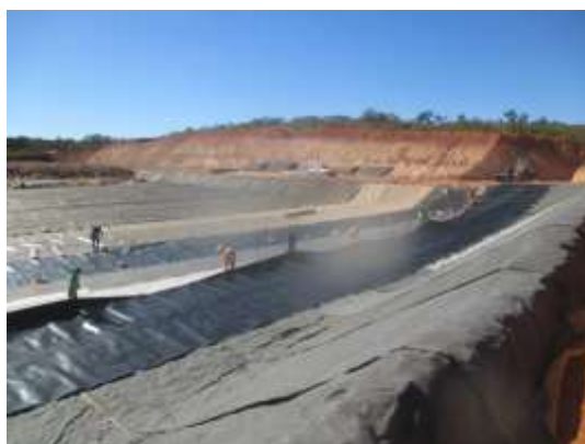
Figura 4a - Implantação de Mantas PEAD 2mm
