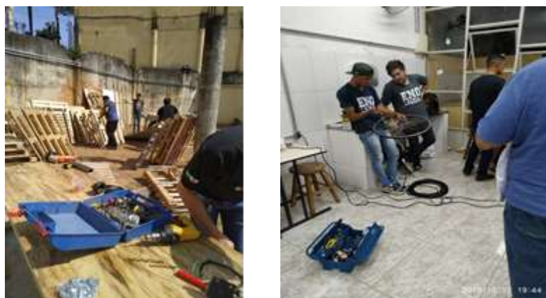
Figura 3: Equipe de pré-montagem dos pallets em madeira e equipe de montagem elétrica.
