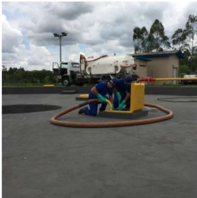
Figura 5 – Retirada de espuma com caminhão de sucção
