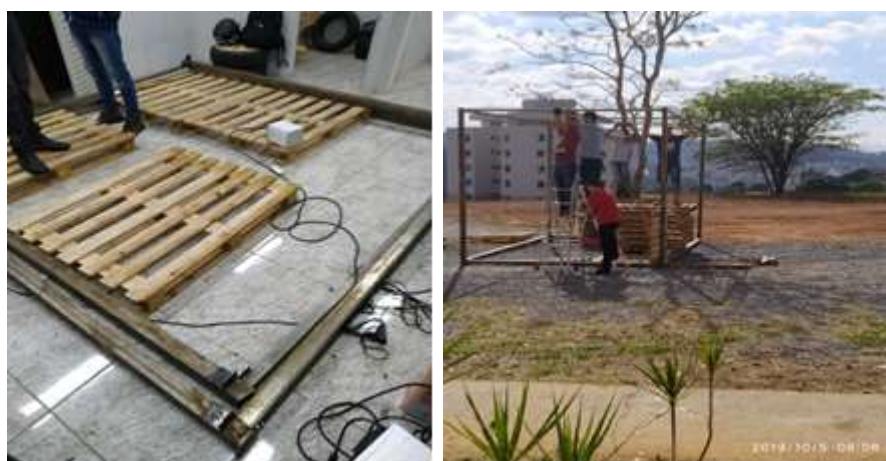
Figura 4: Equipe de pré-montagem dos pallets em madeira e equipe de montagem elétrica.
