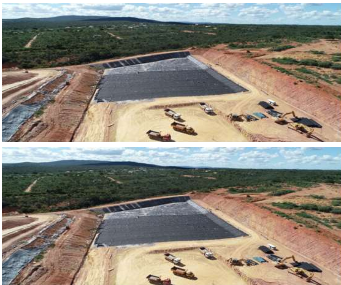
Figura 4c - Vista geral do sistema de Impermeabilização
