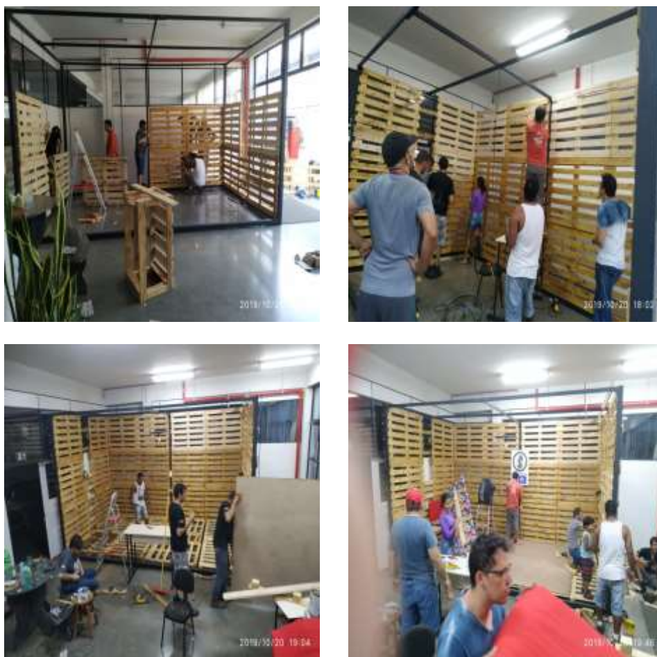
Figura 7: Montagem do protótipo e instalação elétrica.
