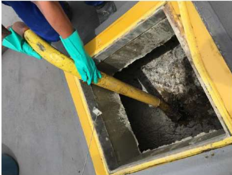
Figura 7 – Retirada de espuma com caminhão de sucção.
