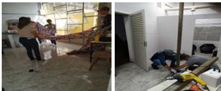
Figura 2: Equipe pré-montagem estrutura metálica e equipe montagem estofado.
