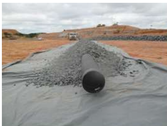
Figura 5b - Drenos horizontais
