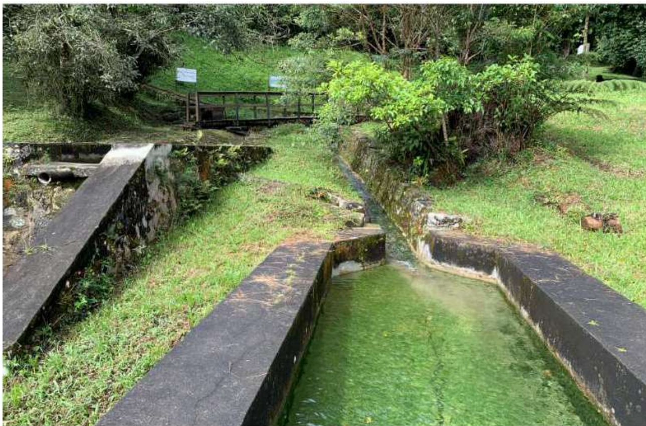
Figura 1 – Captação da água
