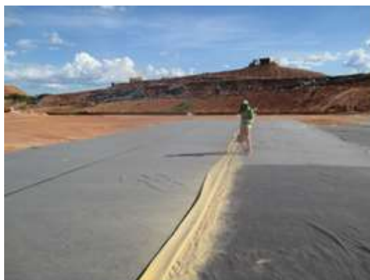
Figura 4b - Aplicação do GCL
