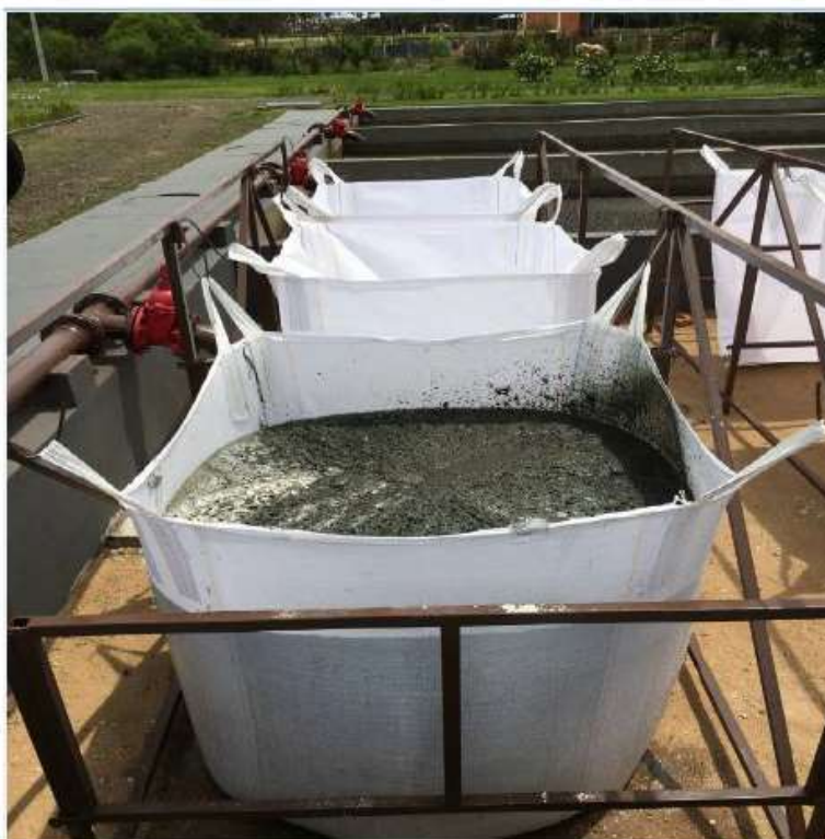
Figura 4 – Big Bags instalados sobre o leito de secagem em estruturas metálicas
