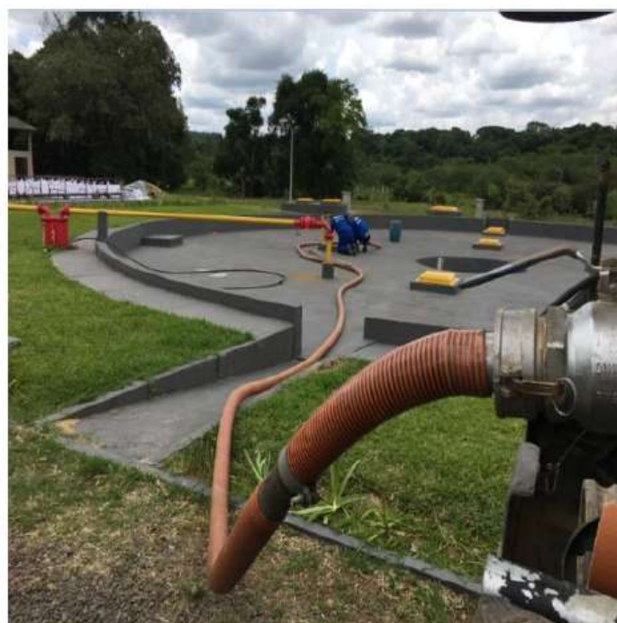
Figura 6 – Retirada de espuma com caminhão de sucção
