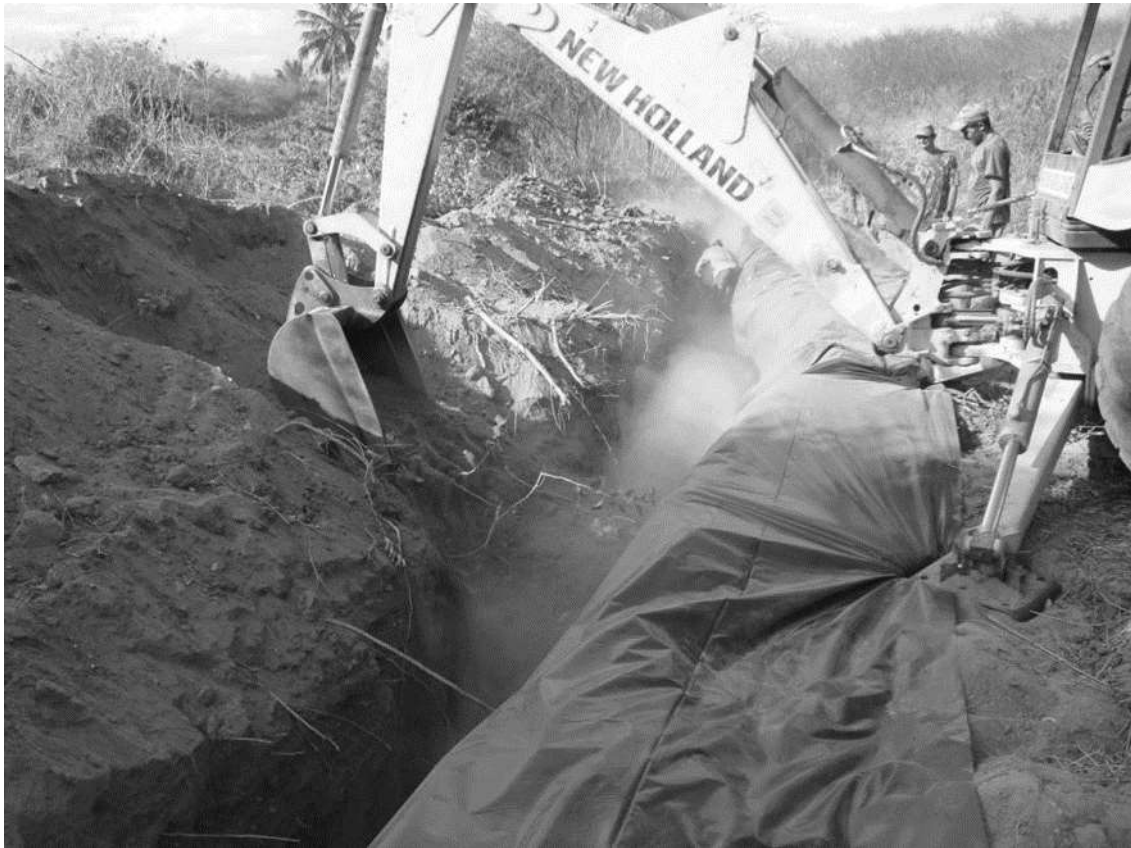
Fig. 4 Etapa final da construção da barragem subterrânea
