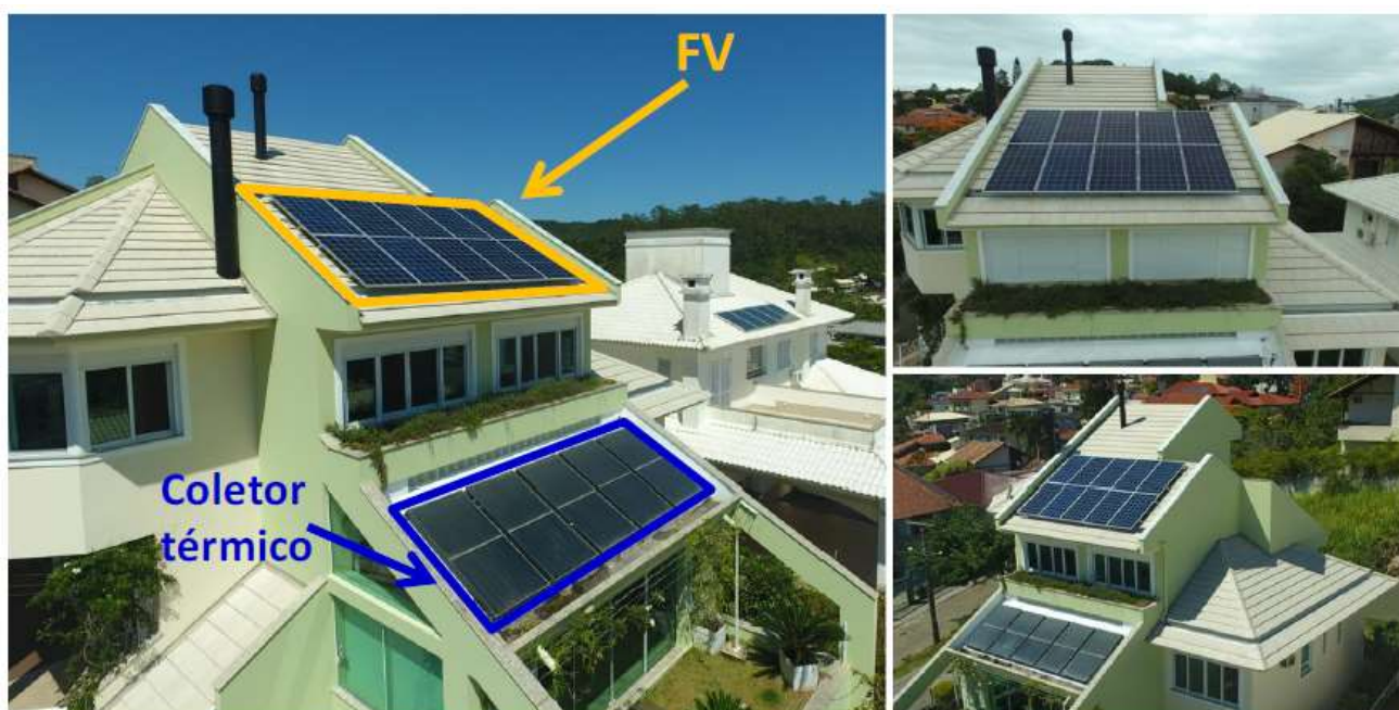
Fig. 4 – Kit FV e coletores térmicos aplicados à cobertura da residência contemplada pelo Programa Bônus FV.
