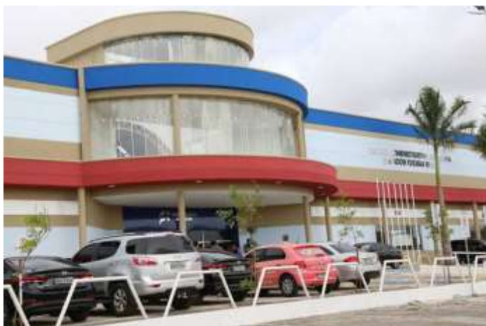
Figura 1. Fachada da Secretaria de Estado da Saúde de Sergipe.
