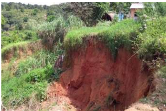
Figura: 02 – Voçoroca próxima a moradias na V. Caburi.
