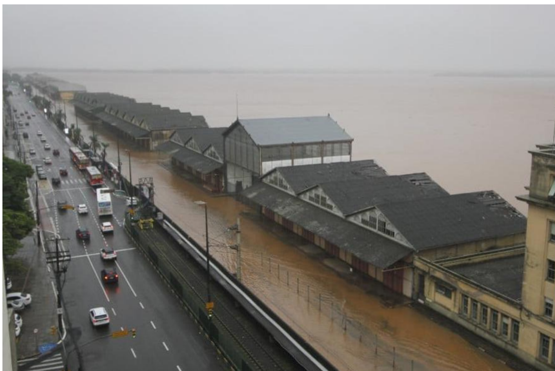
Figura 10: Visão do muro do cais Mauá com a inundação de maio de 2024
