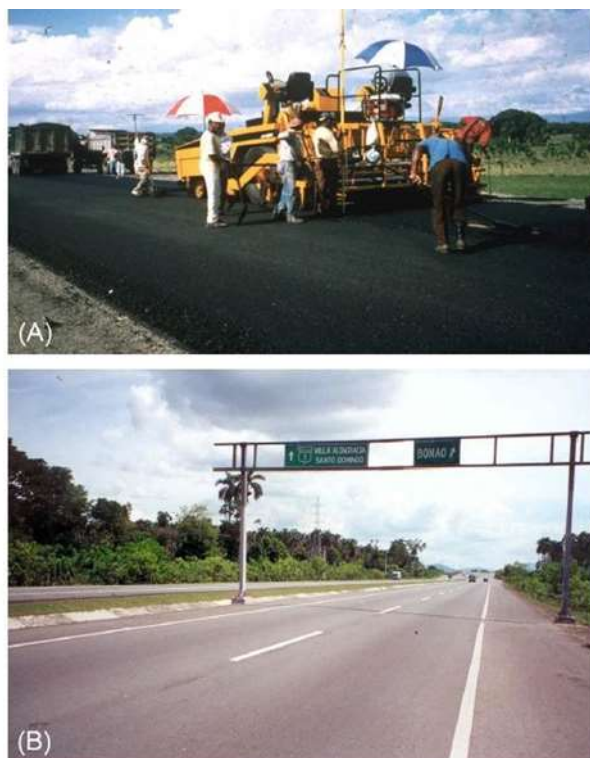
Figura 2.11 - Rodovia Duarte, República Dominicana: (A) Pavimento de concreto asfáltico contendo agregado de escória de níquel. (B) Rodovia 5 anos após sua construção.
