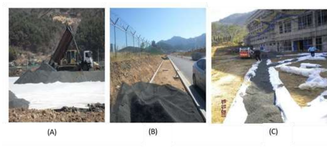
Figura 2.12 - (A) Dreno horizontal no Complexo Industrial de Gwangyang; (B) Construção de calçada no Píer Yeosu Oil and Chemical e (C) Dreno horizontal na Suncheon Lakehills Front Plaza.
