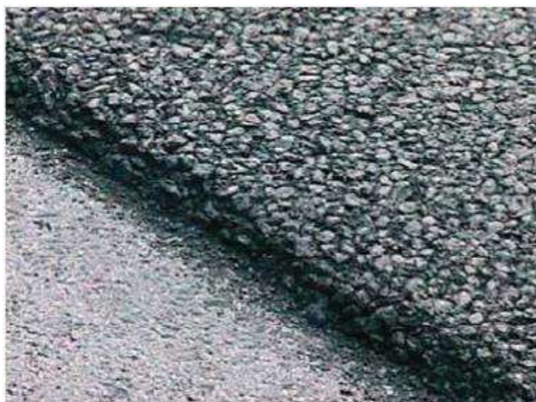
Figura 13 – Detalhe da superfície de um pavimento com SMA
