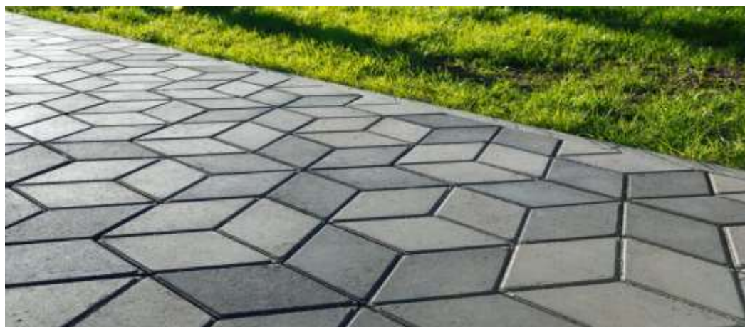
Figura 11 – Exemplo de Pavimentação com Bloquete Intertravado
