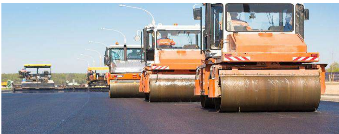
Figura 7 – Ilustração Pavimento Concreto Compactado a Rolo (CCR)
