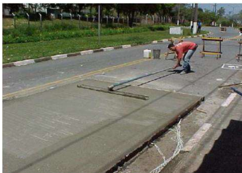
Figura 10 – Aplicação de Whitetopping
