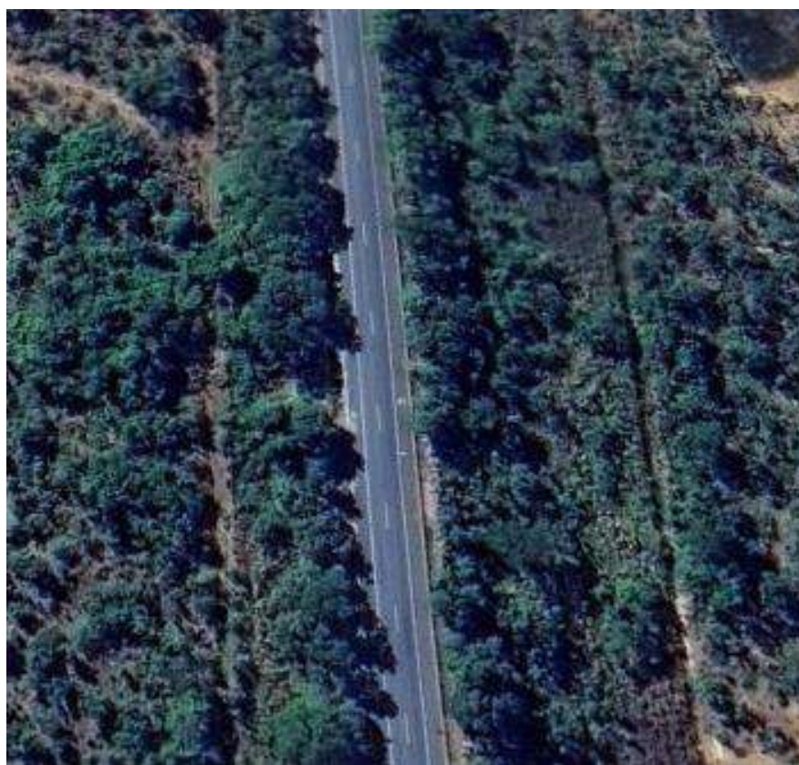
Figura 28 - Trecho do Km 77 ao 78, vista aérea.
