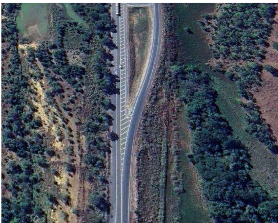
Figura 26 - Trecho do Km 71 ao 72,8 vista aérea.
