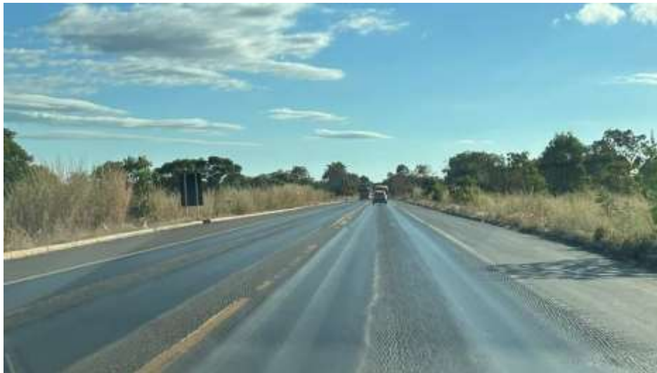
Figura 17 - Registro de má qualidade de via, próximo ao povoado do JK
