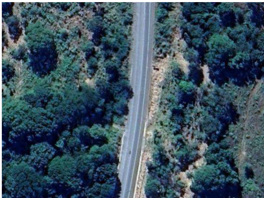
Figura 24 - Trecho do Km 58 ao 59, vista aérea.
