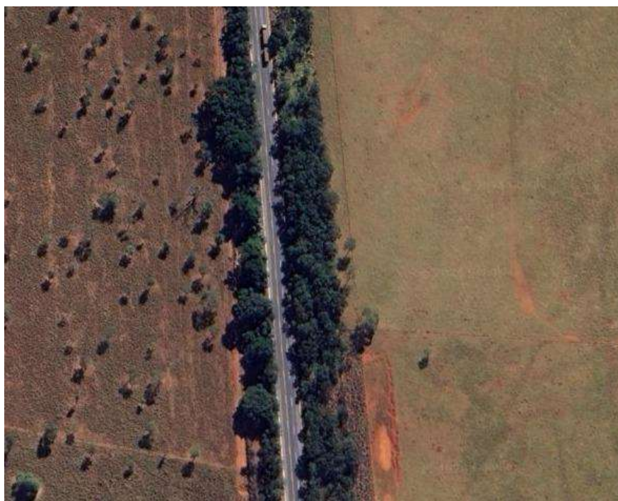
Figura 22 - Trecho do Km 37 ao 38, vista aérea.
