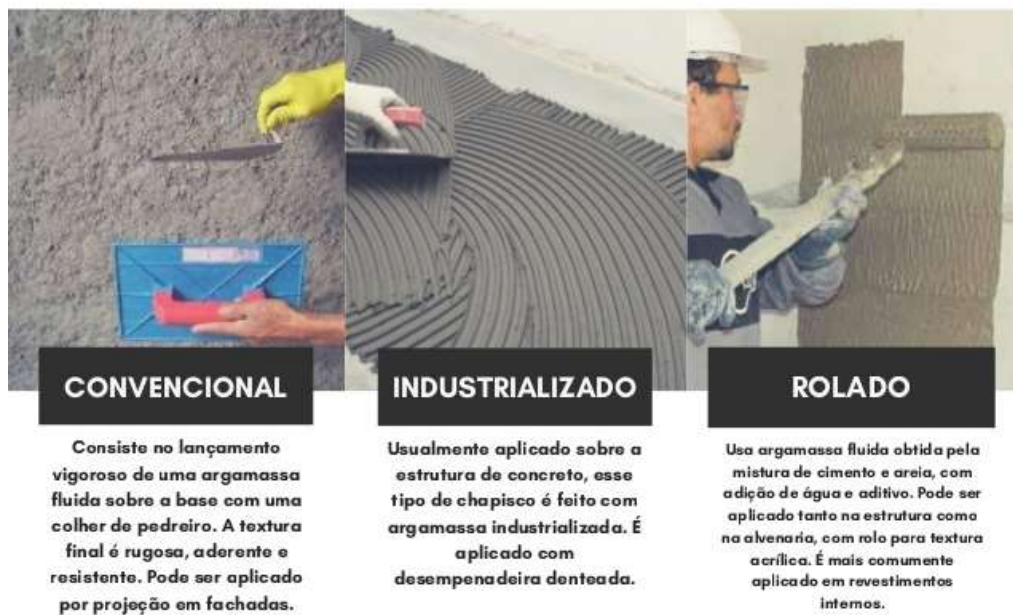
FIGURA 1 – Formas de aplicação do chapisco
