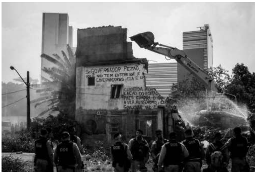
Figura 21. Demolição da casa-símbolo local.
