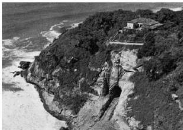
Figura 11. Construção do Elevado do Joá (1968). Fonte: Disponível na internet.
