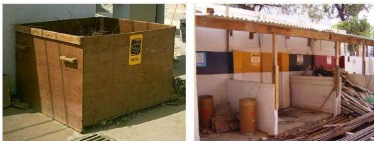
Figura 1- Acondicionamento dos Resíduos da construção civil no canteiro de obra
